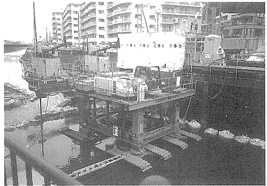
写真-8 MAB 施工状況
