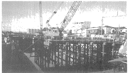
写真-9 仮設栈橋施工例
