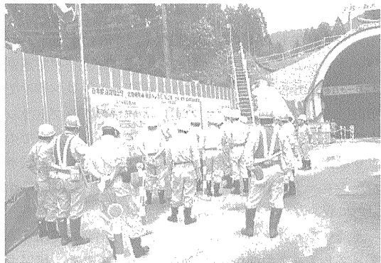
写真-1 工事概況説明
