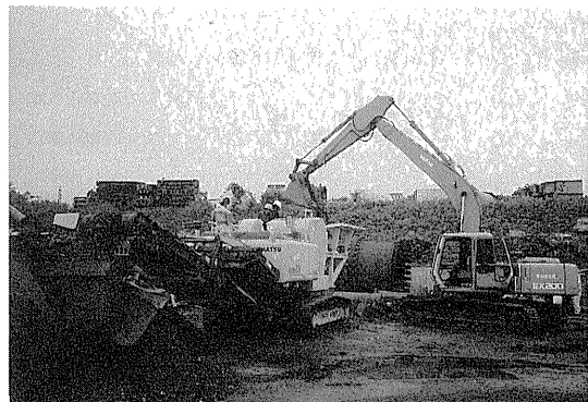
写真-2 自走式破碎機による内容物の破碎状況
