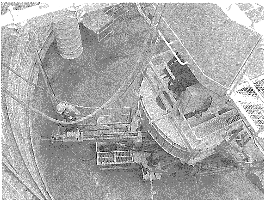
写真-7 ロックボルト削孔状況
