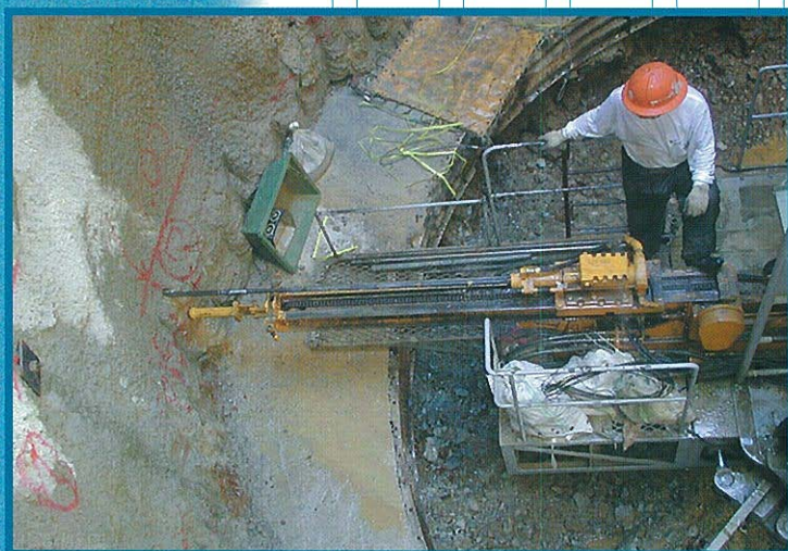
↑ロックボルト用穿孔状況
