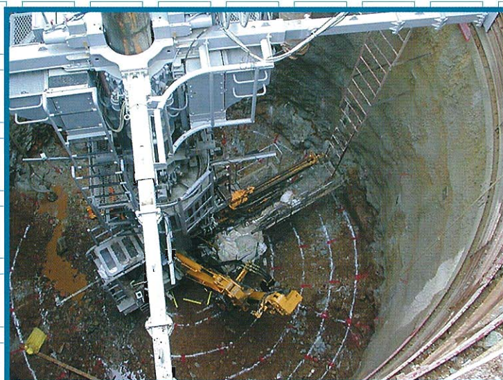
↑発破穿孔作業状況全景
