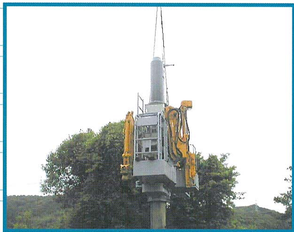
↑機械組立①:掘削・削岩機部
