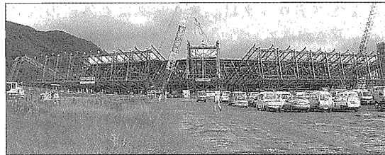
写真-5 地切り完了外観
