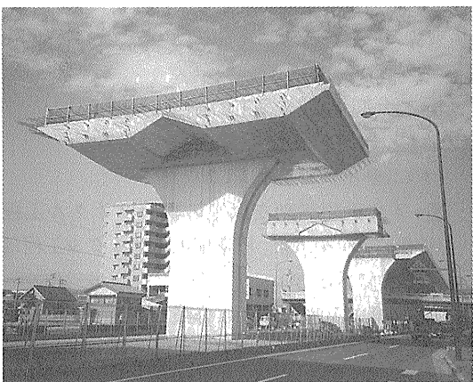
写真三 全断面柱頭部
