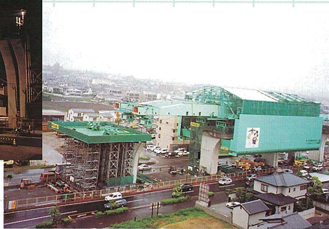
⇩後退前の大型移動支保工 (左は仮受けベント)
