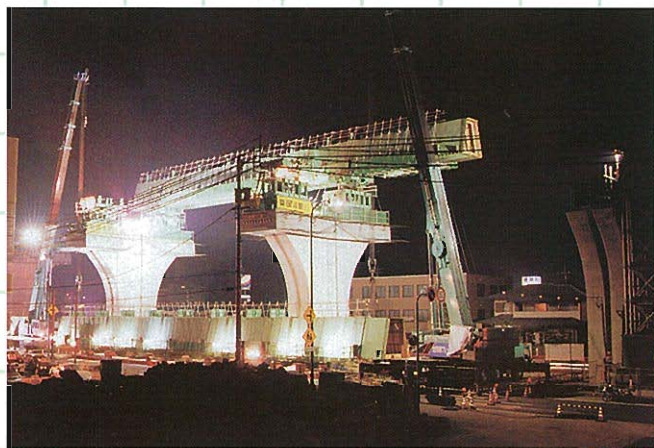
⇩200tクレーン2台による夜間ガーダー架設状況
