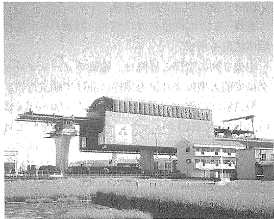
写真-4 大型移動支保工移動状況
