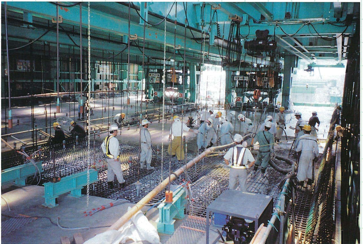
⇩コンクリート打設状況
