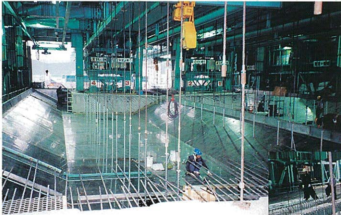
⇩型枠組立状況
