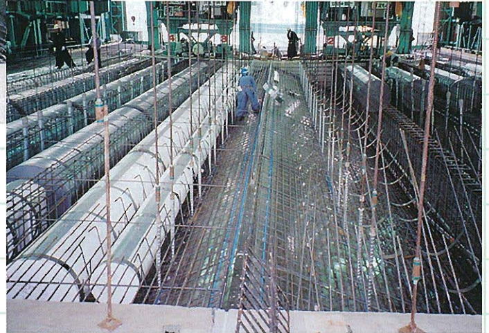
⇩鉄筋組立円筒型枠組立状況
