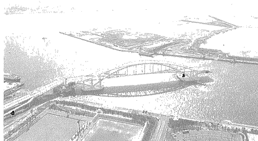
写真—1 橋梁全景（開閉橋時）
