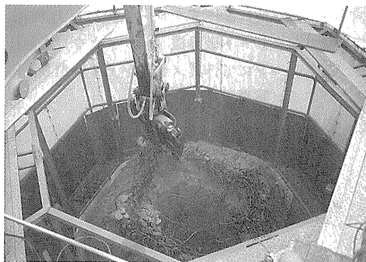
写真-5 圧砕状況
