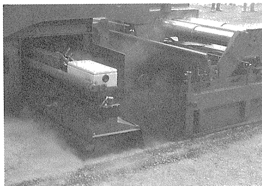
写真-2 乳剤散布状況
