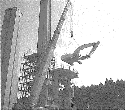
写真—2 コンクリート破碎機設置
