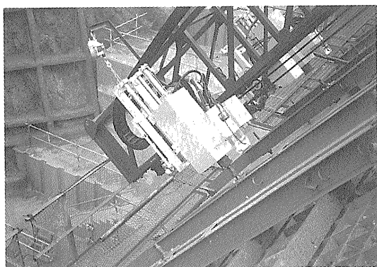
写真一5 ボルト締結作業
