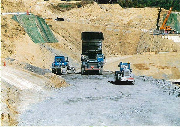
⇩ゾーニング盛土の施工状況
