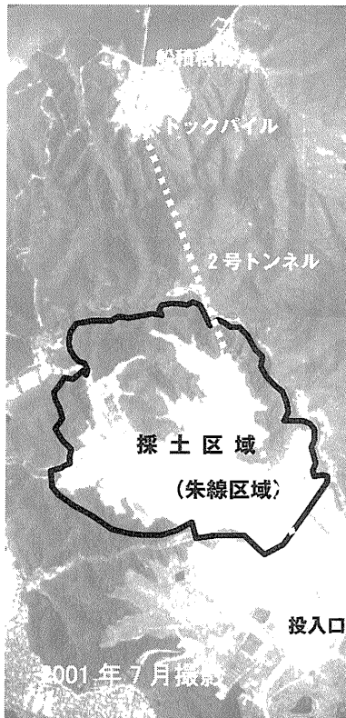
写真-2 加太土砂採取事業全景写真
