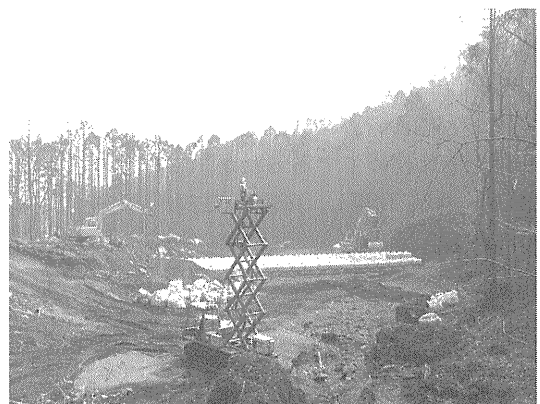
写真三 施工状況
