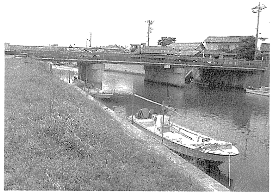
写真-6 施工完了
