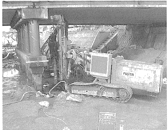
写真一4 削孔状況
