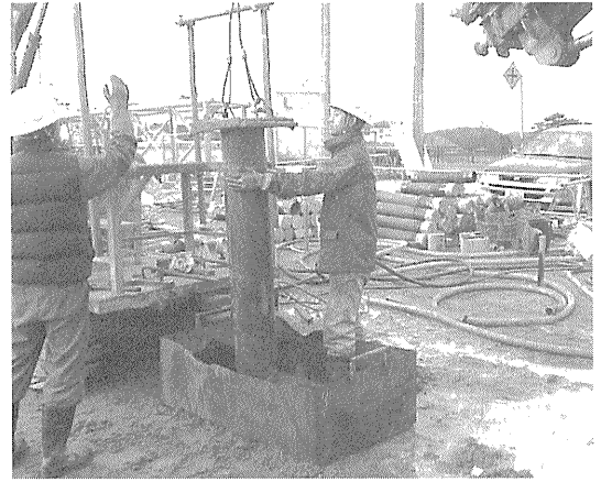
写真一3 鋼製ピットおよびガイド管
