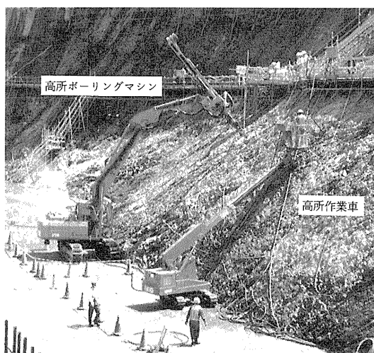
写真-2 施工状況
