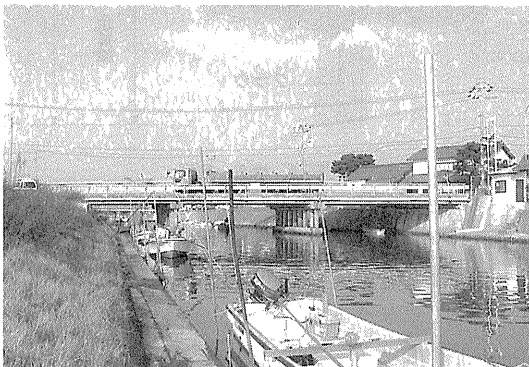
写真1 差海橋着工前全景
