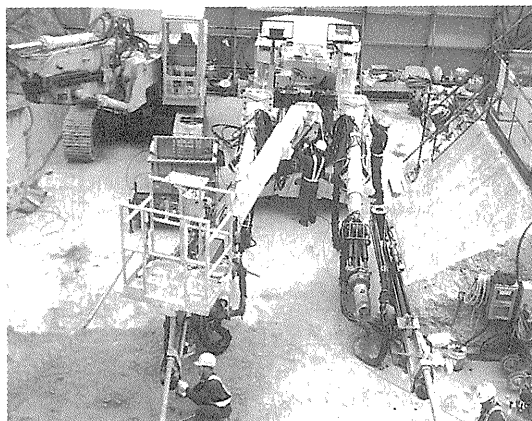
写真-1 穿孔機械全景
