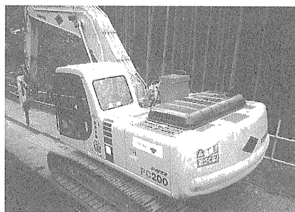
写真-2 バックホウに取付けた火山性ガス対策型C.O.R.
