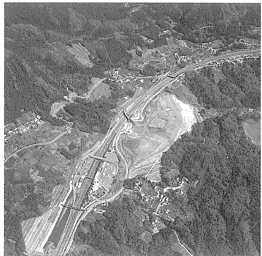
写真-1 談合坂SA(上り)大規模盛土状況(平成11年10月)(甲府方面より東京方面を望む)
