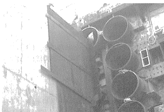
写真-2 函体サイドばね板およびパイプルーフ
