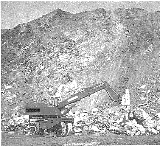
写真—6 昭和 40 年代の空圧ブレーカ作業
