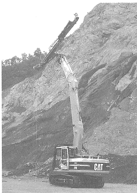
写真—9 ドリル搭載油圧ショベル
