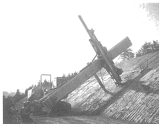
写真—12 オートボルトセッタによる施工
