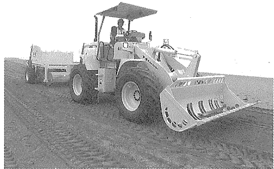
写真—5 稼働風景
