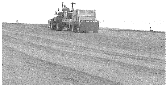
写真—6 稼働風景
