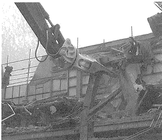
写真7 鉄骨カッタによる解体作業
