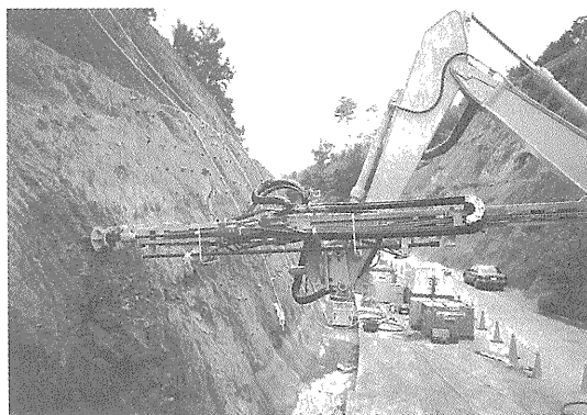
写真—10 穿孔作業
