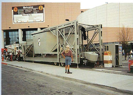
⇩コンクリートプラントを横倒しにして格納しているところ
