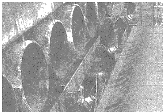
写真-1 函体頂部ばね板およびパイプルーフ
