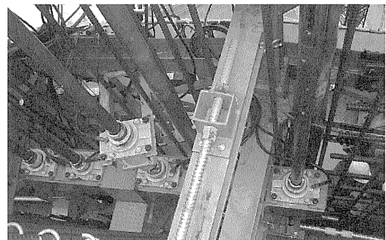
写真—4 上昇ジャッキと反力ロッド
