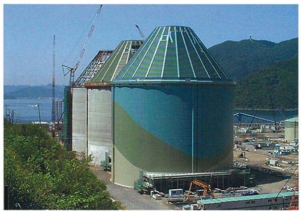
⇨筒体塗装仕上工事
