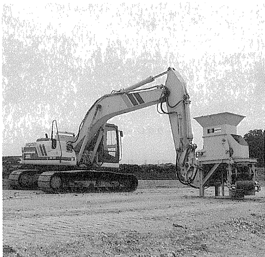
写真-2 バックホウに装着された撒きだし装置
