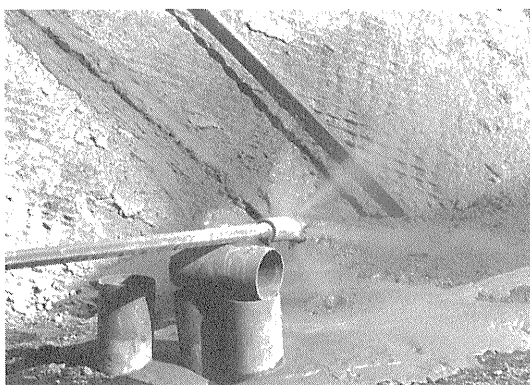
写真-1 セメントミルクとエアの噴射状況
