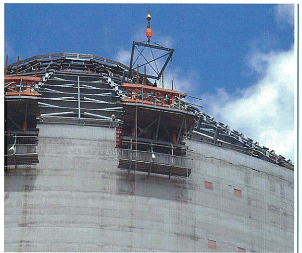
⇩スリップアップ装置解体
