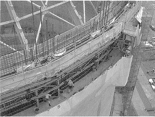
写真—2 スリップアップ装置 (左：外側，右：内側)
