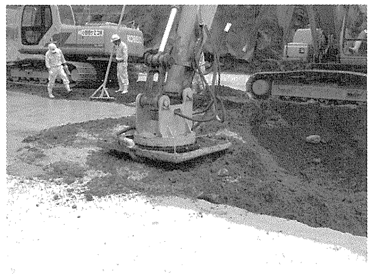
写真-2 攪拌混合状況
