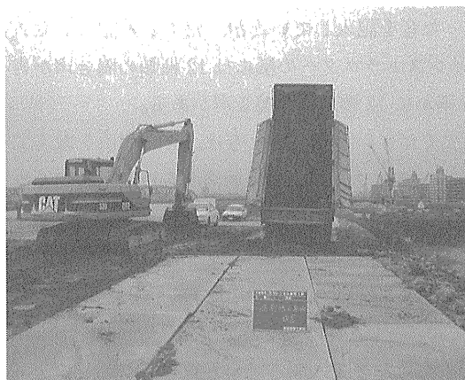
写真—4 高規格堤防への再利用状況
