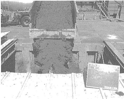
写真—3 改質土を養生ピットへ投入する状況
