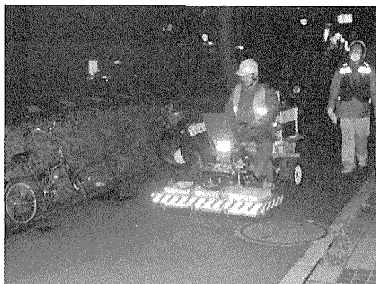
写真-3 現場試験状況
