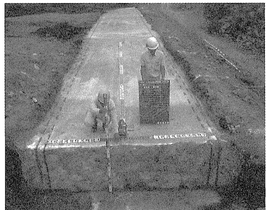
写真-5 出来形確認状況
