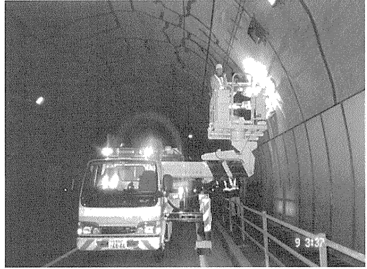
写真-6 Tトンネル (10測線)
