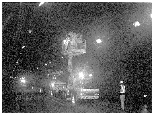
写真-4 Kトンネル（5測線）
