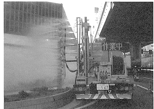
写真-9 透光性遮音壁清掃車作業状況
