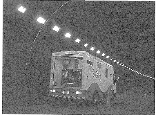
写真一 レーザクラック計測状況
