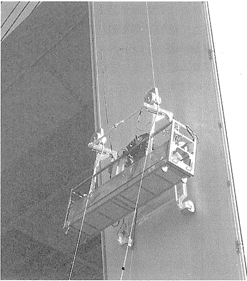
写真—1 オーバハング部を昇降する磁石車輪ゴンドラ
