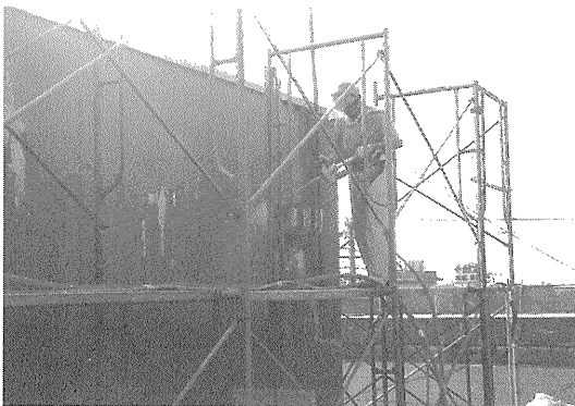
写真—5 外壁塗膜剥離 使用水：250 MPa×6 L/min 使用機器：ハンドガン
