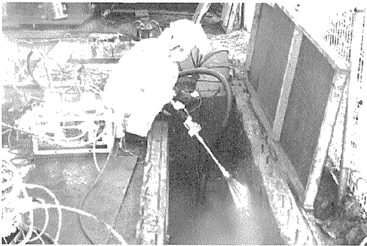
写真—3 浄化槽内のチッピング 使用水：250 MPa×6 L/min 使用機器：ハンドガン
