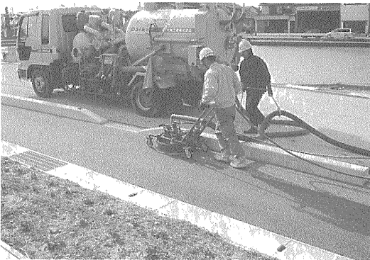
写真—4 舗装表面洗出し施工 使用水：250 MPa×30 L/min 使用機器：台車式ノズルユニット
