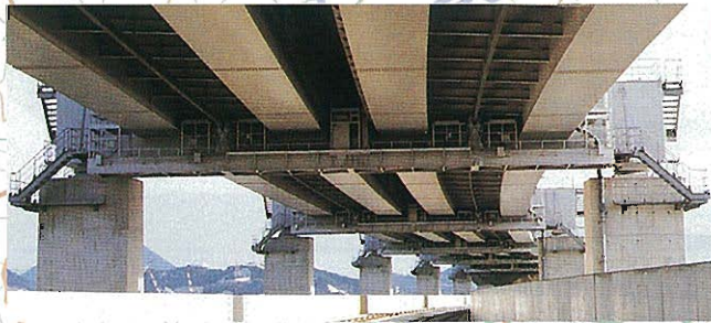
↑高架橋(共用部)用作業車(番の州高架橋)
