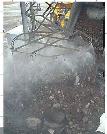
投入口:投入状況1
