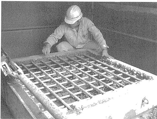
写真-7 はつり施工能力テスト状況
