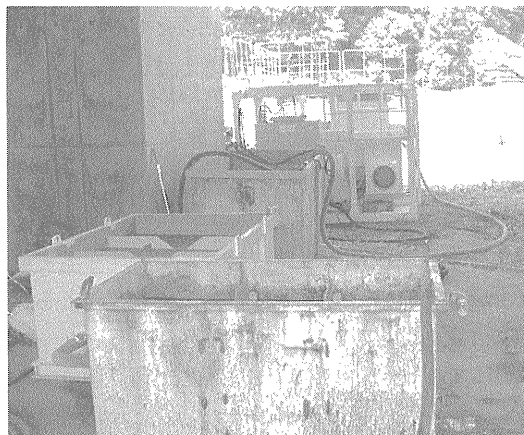
写真—5 はつり廃水の循環状況
