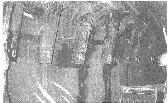
写真—7 側壁導坑への到達状況
