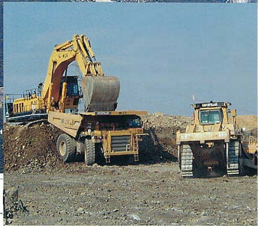
切羽:積込状況
