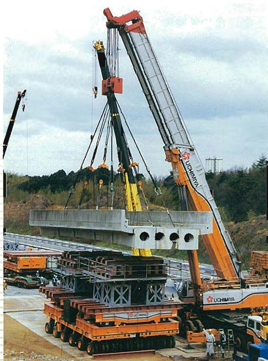
⇩500tH/cで190tの中央径間を吊り上げたところ
