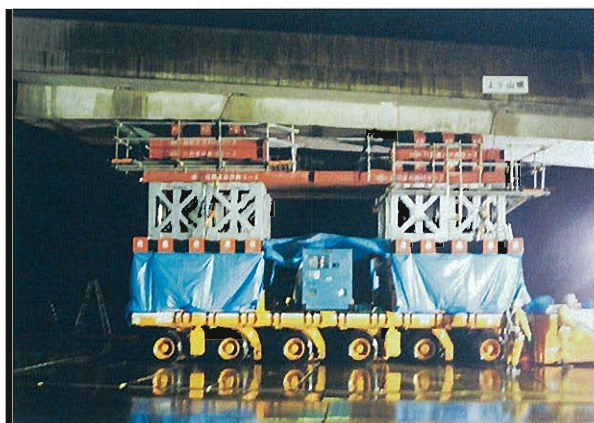
⇩中央径間(190t)を撤去した1号機
