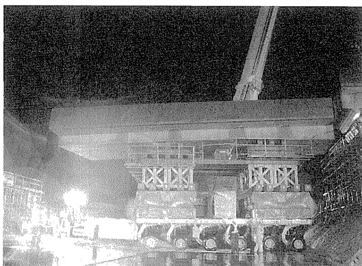
写真五 ジャッキを下げ移動し始めた1号機
