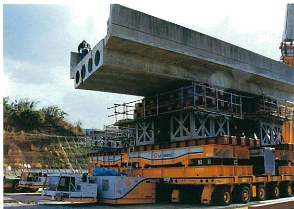
⇩1号機上の下り線側中央径間
