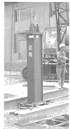
写真-1 スルーパス杭芯材建込み状況
