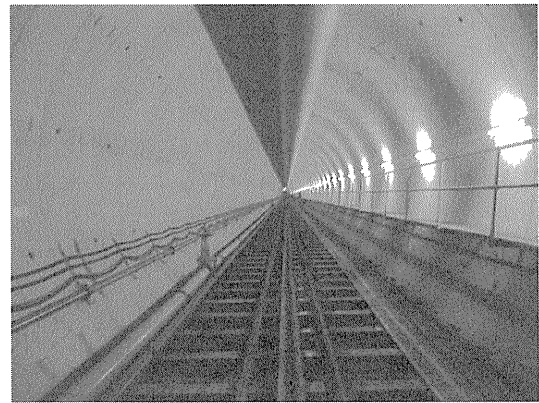
写真-4 セグメント組立て状況
