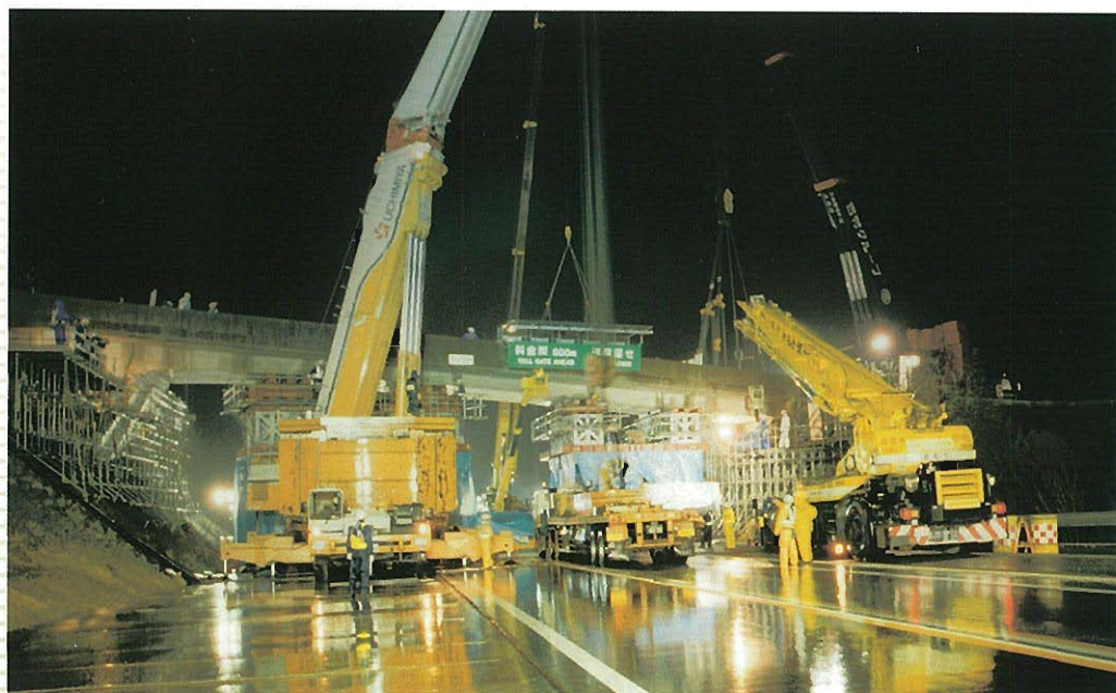
⇨撤去現場全景
