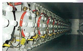
⇨スポーク内からリレービット 装着部を見る(左側が切羽)
