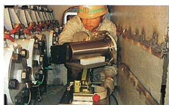
⇨リレービット引き出し状況 (左側が切羽)
