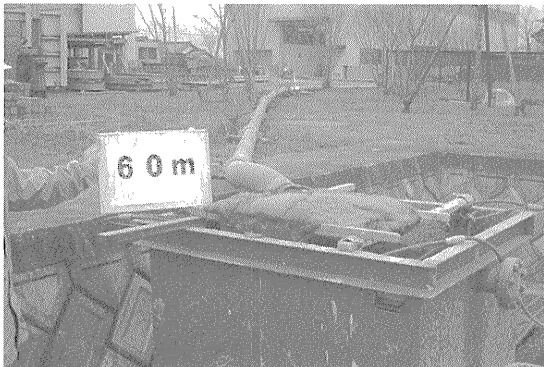
写真-5 排土状況 (圧送距離 60 m 地点)
