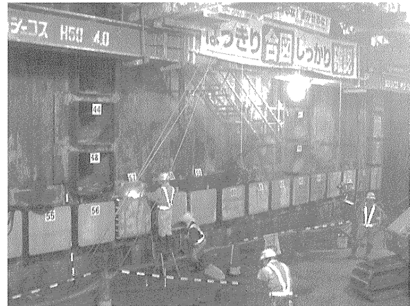
写真-4 完成した三連ボックス
