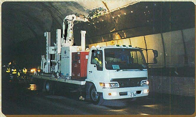
⇩ 打音診断機全景
