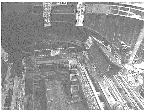
写真-3 発進架台
