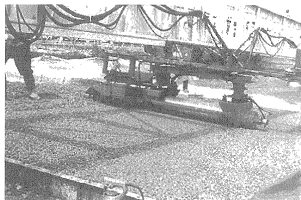
写真-2 シリンダフィニッシャによる敷きならし状況および締め状況
