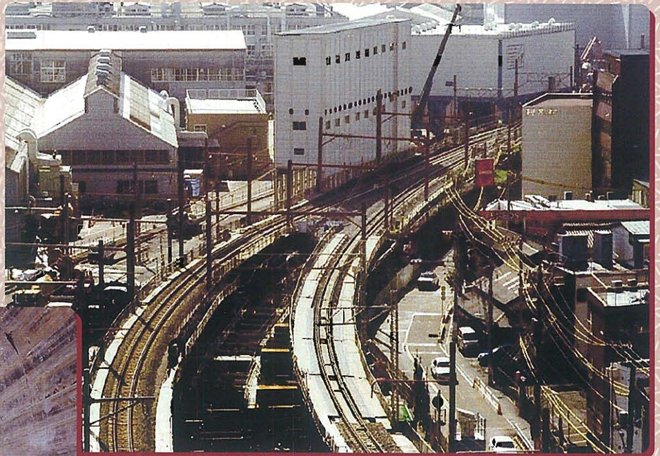
施工途中全景⇒
