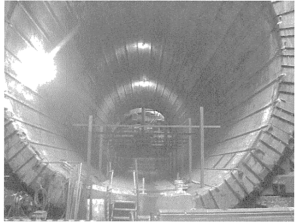
写真-6 閉合部(コンクリート打設後)
