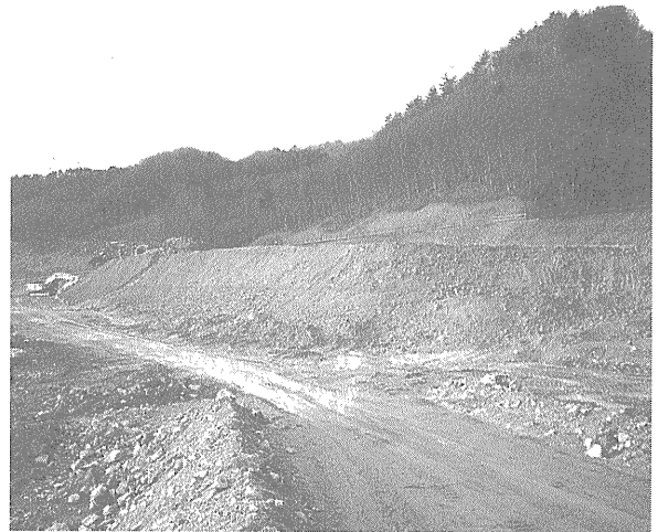
写真-3 施工部位
