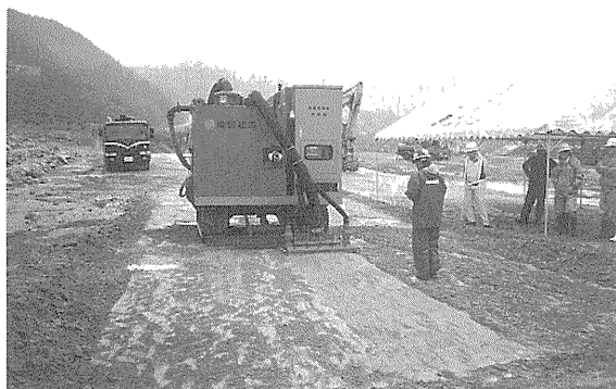
写真-3 無線操縦による清掃状況
