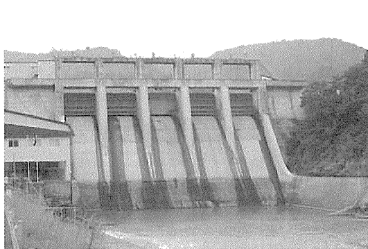
写真-7 竣工後ダム全景
