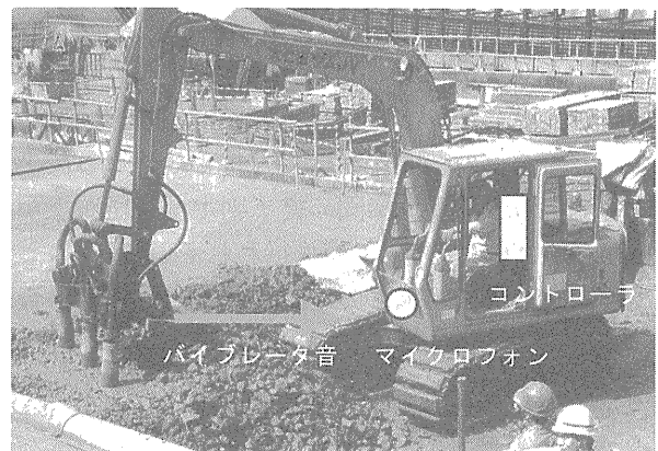
写真-3 締固め時の音の測定方法
