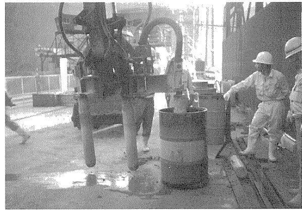
写真-1 現場締固め試験状況
