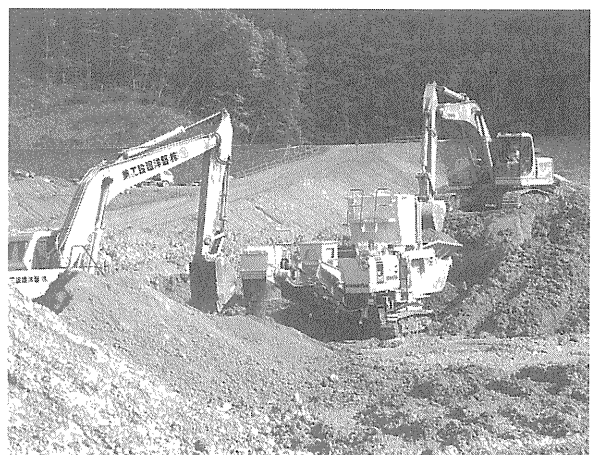
写真-1 改良状況
