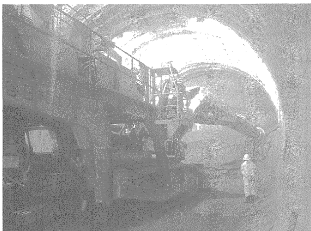
写真-1 自由断面掘削機
