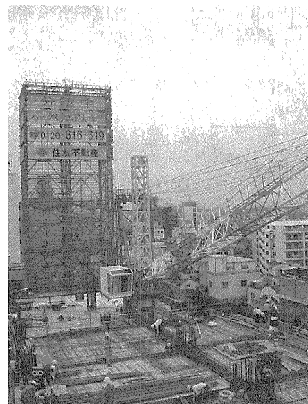
写真二 フロアクライミング状況
