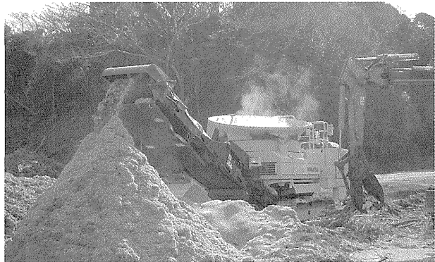
写真—8 リフォレ BR 120 T による破碎状況
