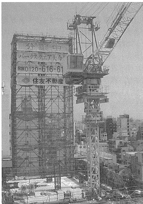
写真一 タワークレーン設置状況
