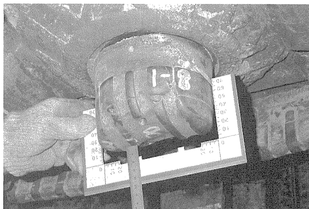
写真—3 リレー先行ビット（1～8）摩耗確認状況
