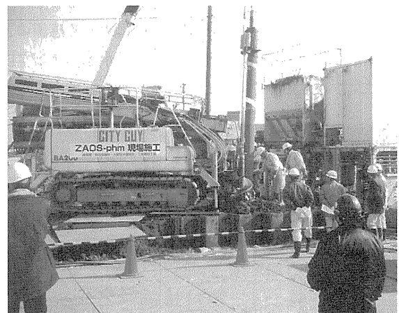
写真-1 ハイブリッドパイルの建込み
