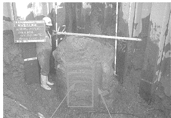
コア採取跡② 3 番の杭を削孔する際に削り取られた箇所
