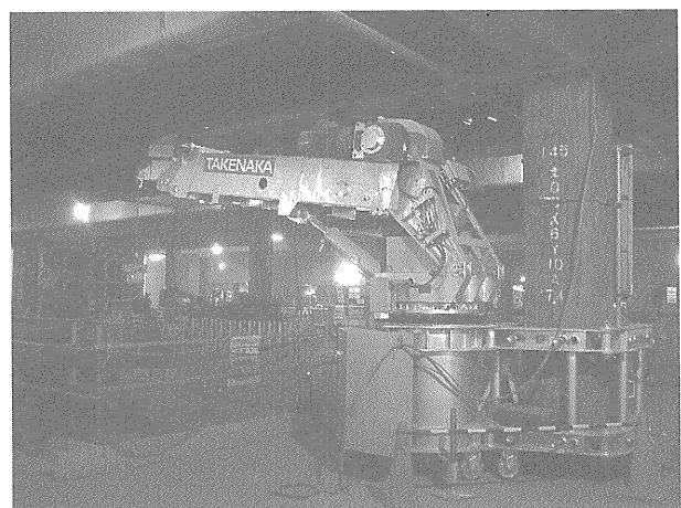
写真-2 設置状況 (その2)
