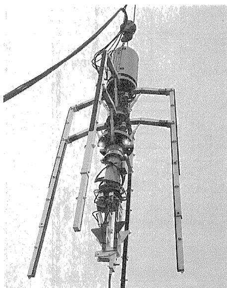
写真-2 頂部作業用バー取付け状態 (2号機)
