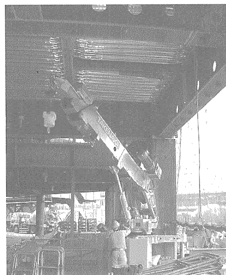
写真-1 設置状況 (その1)
