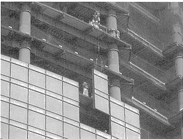
写真-4 外装取付け用ジブクレーン使用状況
