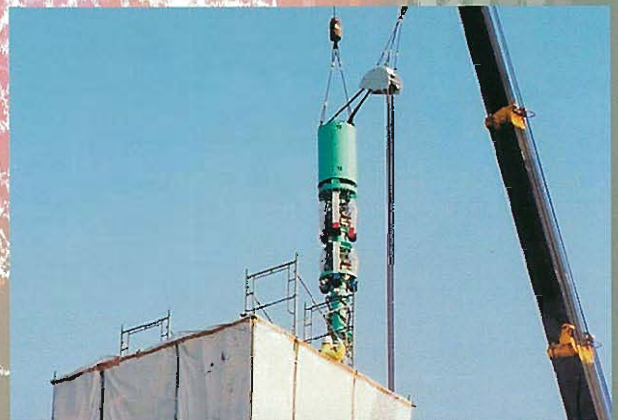
⇩頂部ロボット投入状況(2号機)
