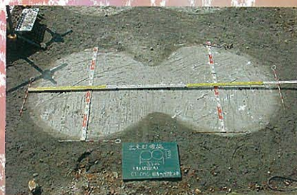
↑改良体出来形(翼径1.6m×2軸)
