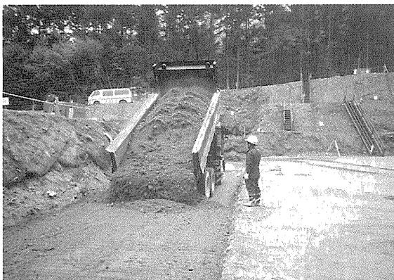
写真-5 施工ヤードへの荷卸し
