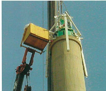
↑1号機による頂部施工状況
