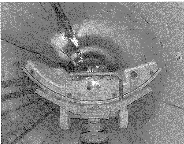
写真-1 ガイドローラ付きタイヤ式搬送車
