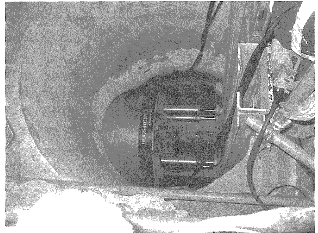
写真-2 工事状況
