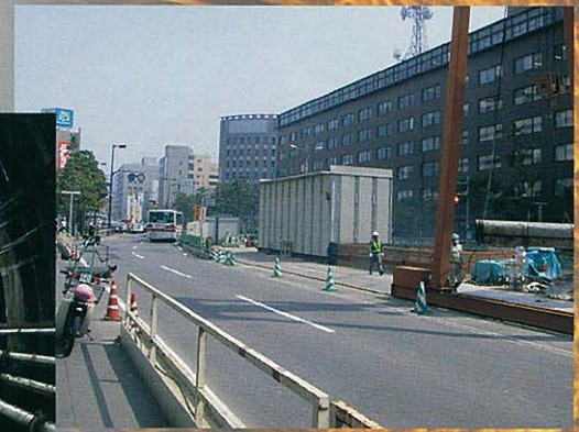
↑発信基地よりシールド進行方向を望む (右側建物角部の下を通過)
