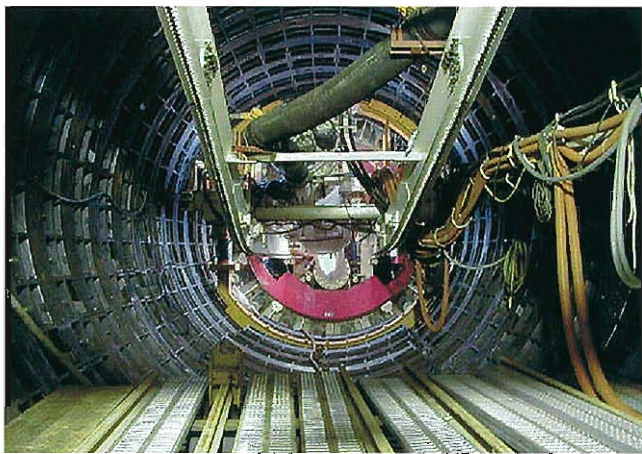
⇩シールド機内状況
