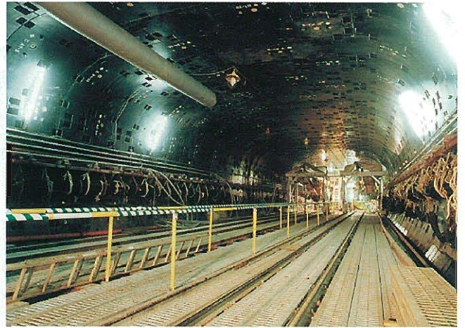
↑ 特殊合成セグメントによる覆工状況（渡り線部）
