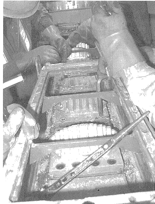
写真—11 特殊先行ビット交換状況
