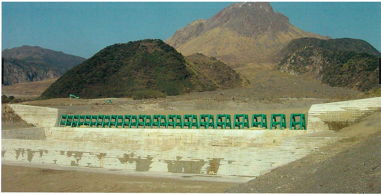
⇨鋼製スリット砂防堰堤完成全景
