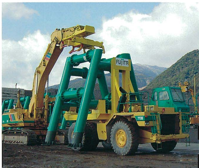
⇩ 鋼製スリットの運搬・把持状況
