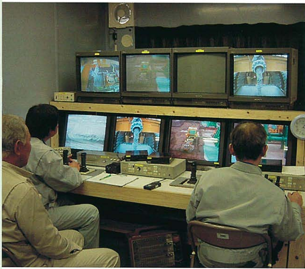
⇨コンクリート打設操作状況
