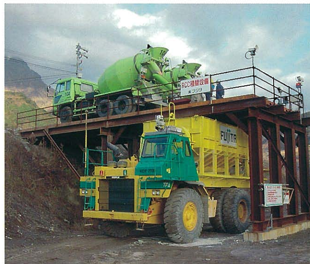
⇩ 高流動コンクリート積替状況
