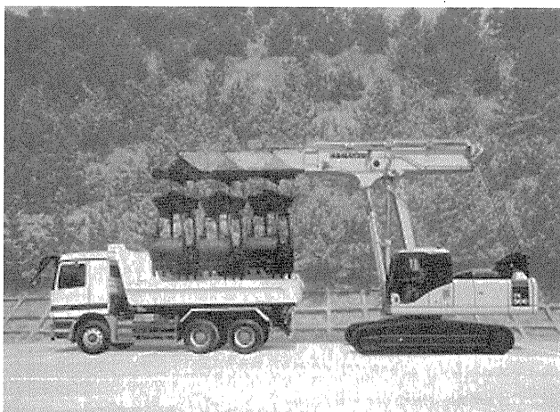
写真-5 ダンプトラック積み込み状況
