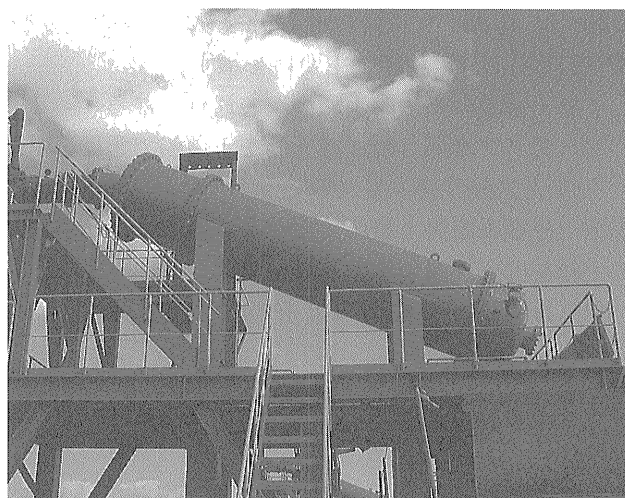
写真-1 ソイルセパレータ
