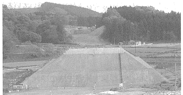
写真-3 試験盛土完成状況（高さ約8.5m）
