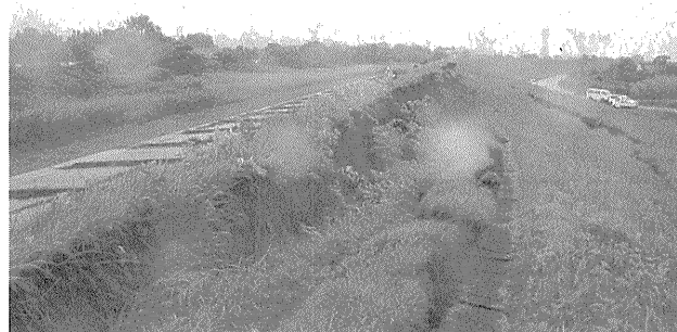
写真—5 鳴瀬川右岸堤防 13.0 km 付近の被災直後の状況 （堤内側に大きく沈下した。撮影：東北地方整備局）
