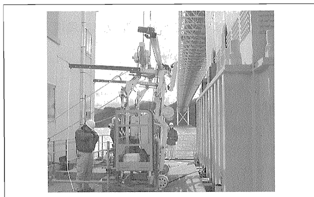
写真—3 塗装装置と磁石車輪ゴンドラ
