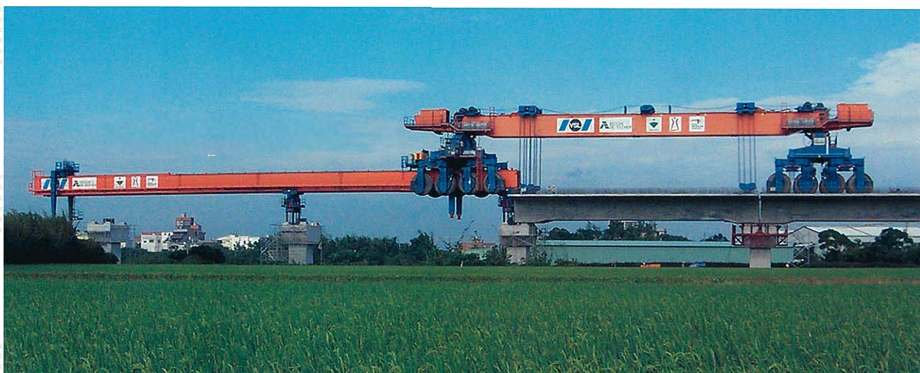
↑ プレキャスト桁の据付終了
