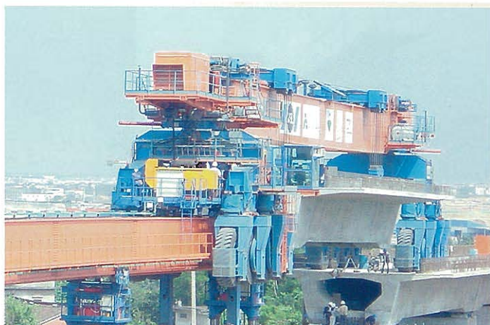
↑↓ サポートビームが前方に押し出され、ラウチングキャリアで運ばれてきたプレキャスト桁が降ろされる
