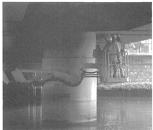
写真-3 橋脚桁下作業
