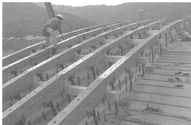
写真—3 第4橋 後詰め、巻金、かすがいが取付けられた状況
