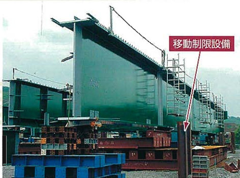
⇩ 走行床面部の送出し桁の地組立て工事
