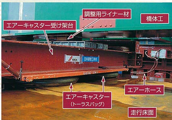
⇩ 走行床面部の送出し桁の地組立て工事
