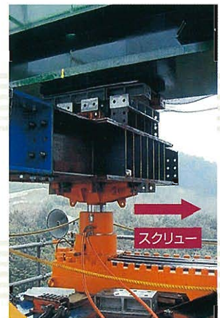
橋台・橋脚上の送出し駆動装置⇨
