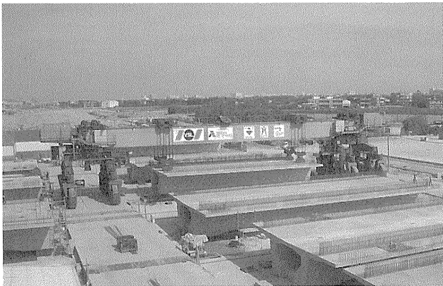
写真—6 桁ストックヤード
