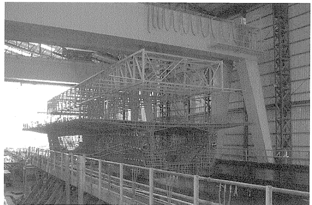
写真—4 プレハブ鉄筋吊込み
