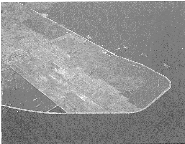
写真-3 導入現場の全景
