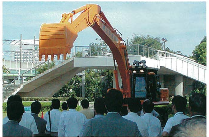
⇩遠隔制御で運転するバックホウ
