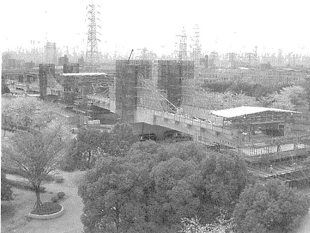
写真1 張出し施工状況
