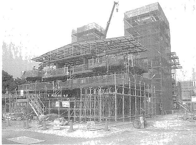
写真一 移動型枠設備全景
