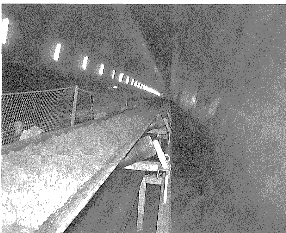
写真—1 ベルコンによるずり出し
