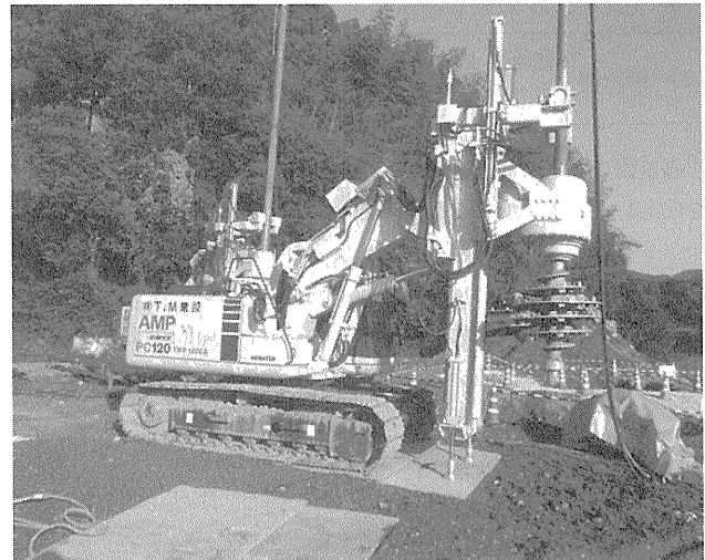
写真-1 AMP 施工機械
