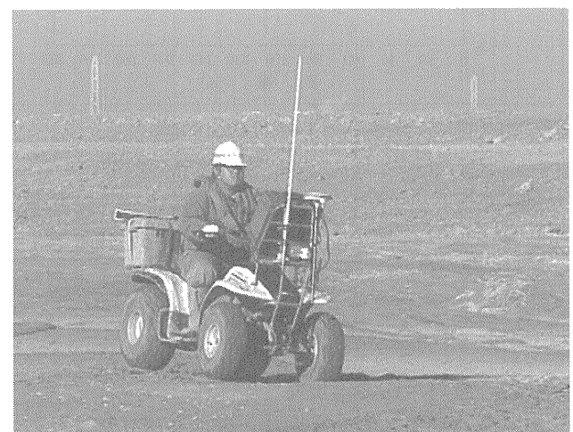
写真-5 現場での測量状況
