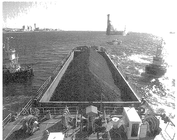
写真-2 導入現場状況
