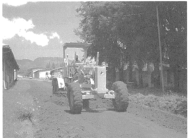
写真-2 仮設道路建設中
