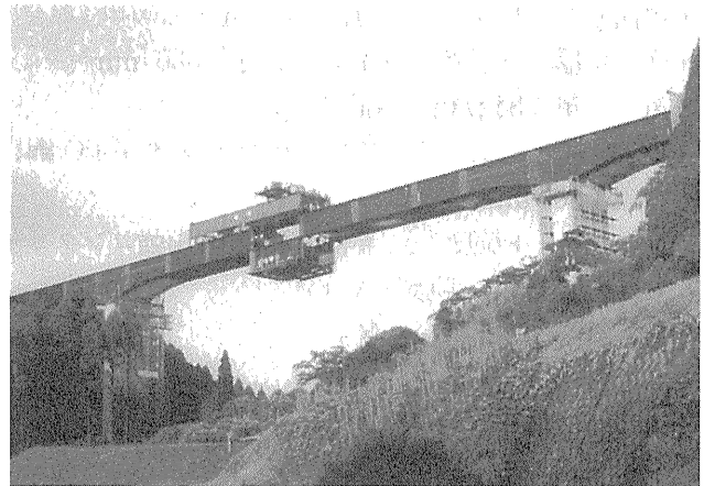
写真一四 中央閉合ブロックの架設状況
