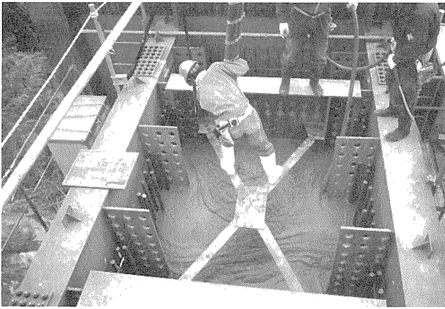
写真—2 剛結部のコンクリート打設状況
