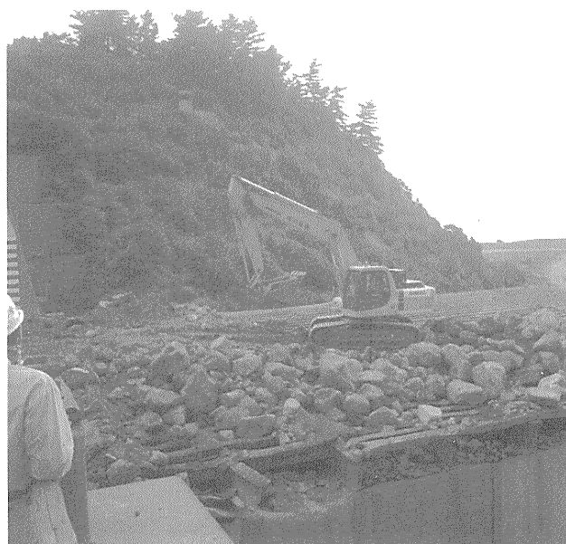
写真一4 桜島山麓のスクリーンダムにおける土石除去作業(鹿児島県野尻川)
