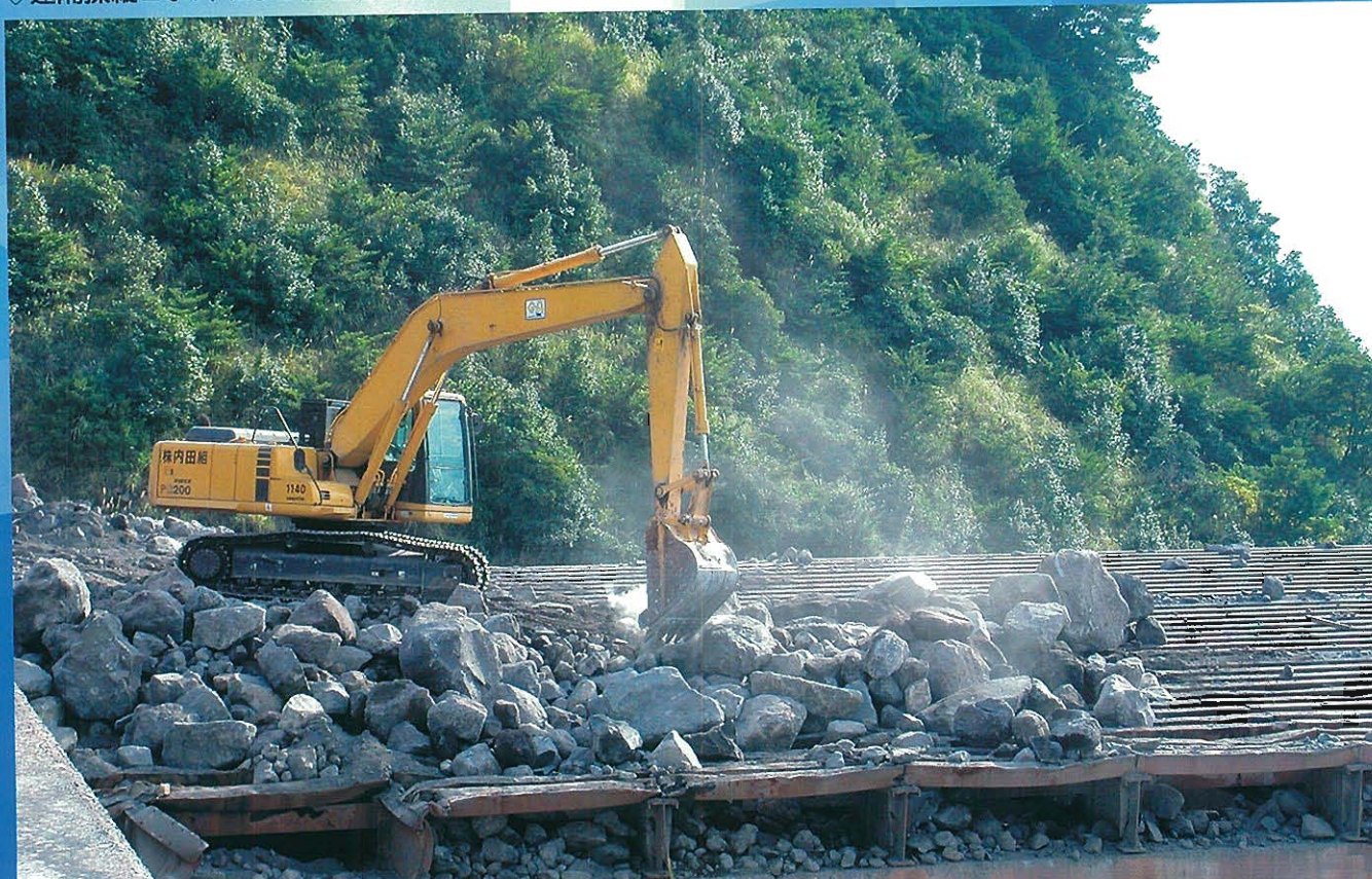
⇓ 遠隔操縦ロボットによる巨石除去作業中
