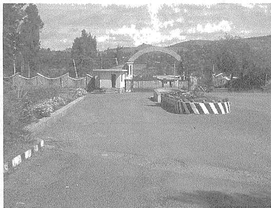
写真—5 コンパウンド施工前
