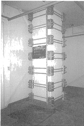
写真-6 RB補強実施例(山形鋼とモルタルの定着部) 写真-7 RB補強実施例(鑄物の定着部)
