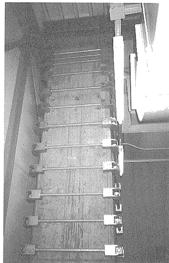
写真-6 RB補強実施例(山形鋼とモルタルの定着部) 写真-7 RB補強実施例(鑄物の定着部)
