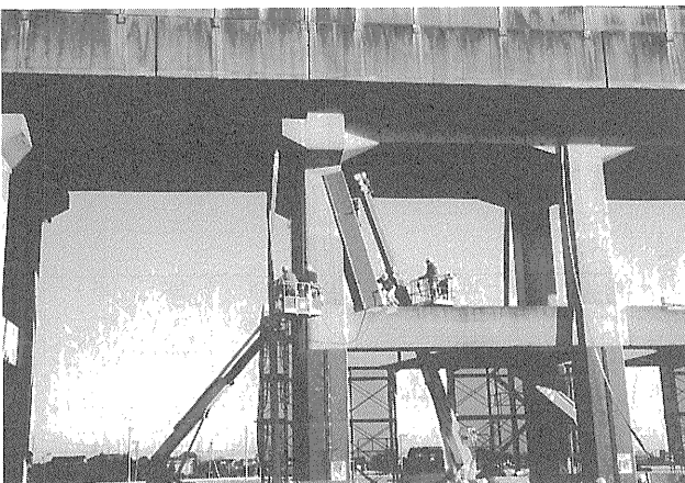
写真-1 鋼板巻き工法 (施工中)
