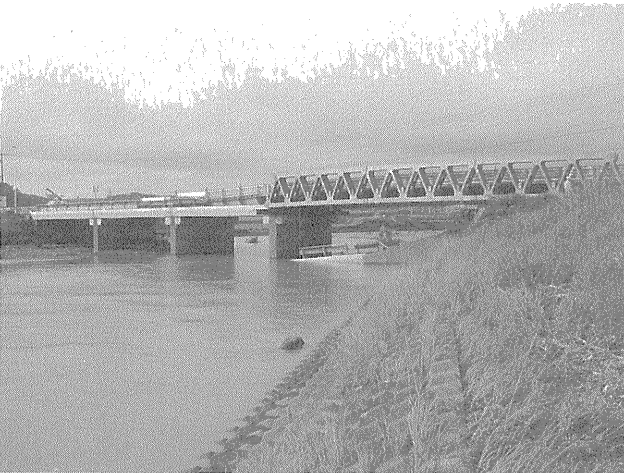
写真一六 応急組立橋架設状況
