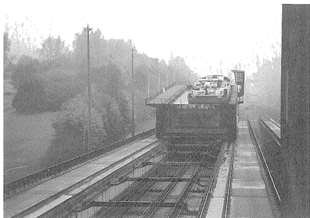
写真—1 ロンキエール・インクライン
