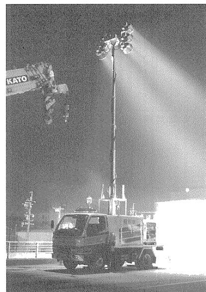
写真—4 照明車作業状況
