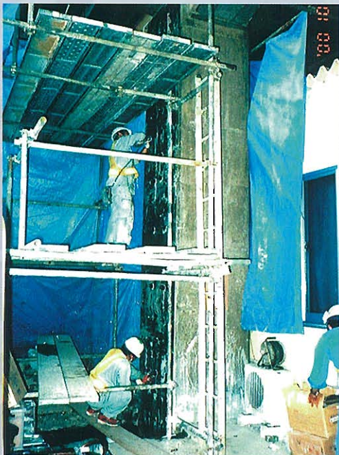
⇧補強鋼板取付け状況
