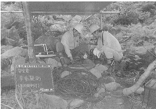
写真-11 地すべり測定：孔内傾斜計
