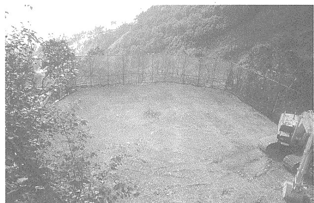
写真—7 施工完了：茶色のネットは景観対策
