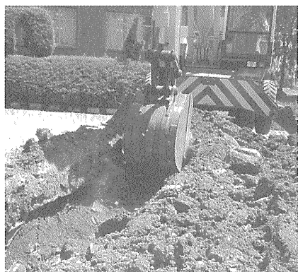
写真-6 建設機械による掘削
