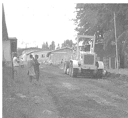
写真-5 グレーダ作業
