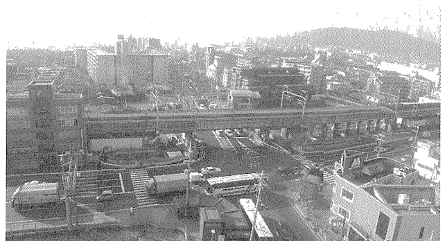
写真—1 工事場所全景
