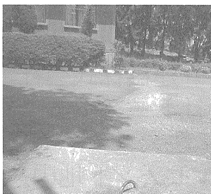
写真-4 側溝工事前
