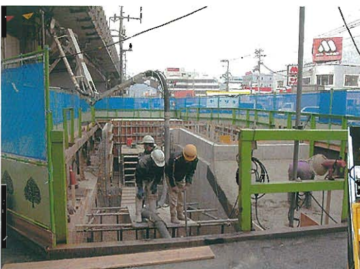
↑現場打ち躯体の基礎コンクリートの打設状況
