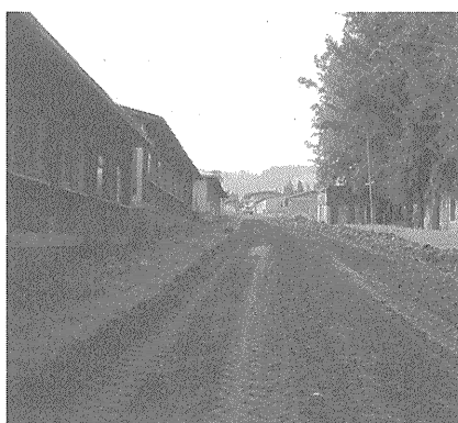
写真-7 グレーダ作業終了
