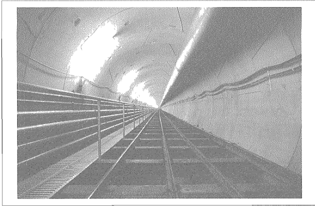
写真-1 坑内直線部
