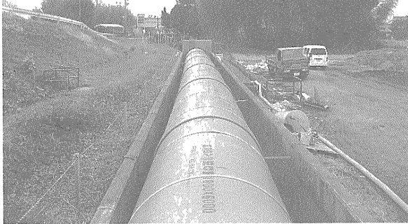
写真-1 管据付け後
