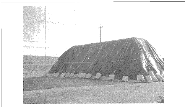
写真—3 シート掛け状況
