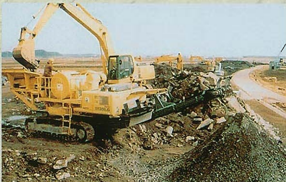
⇩コンクリートガラを破碎、現場内に基礎材として再利用
