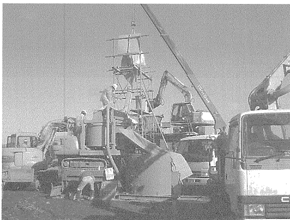
写真—5 混練作業
