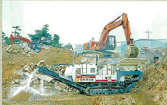
⇩発生岩石を碎石し、再利用
