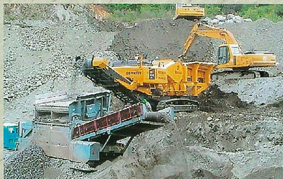
⇩破碎後の岩石をふるい機によりサイズ分け作業中
