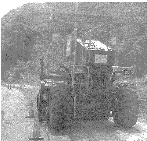
写真—5 破碎状況
