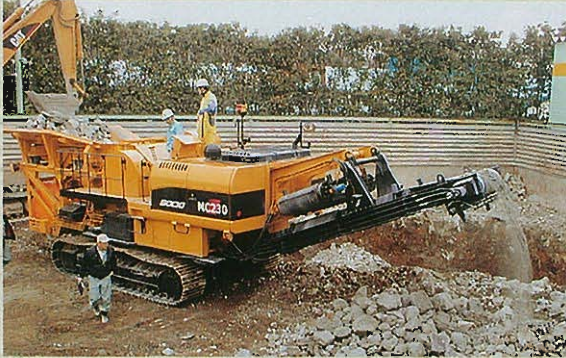
⇩コンクリートガラを40mmアンダーに破碎中
