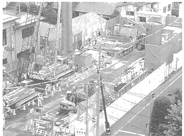
図-11 仙台東部共同溝工事現場の全景
