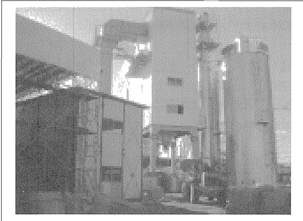
写真—10 組立て後のバッチャープラント全景
