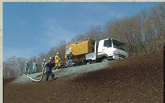
⇩破碎、チップ化された廃材を法面へ吹付作業中
