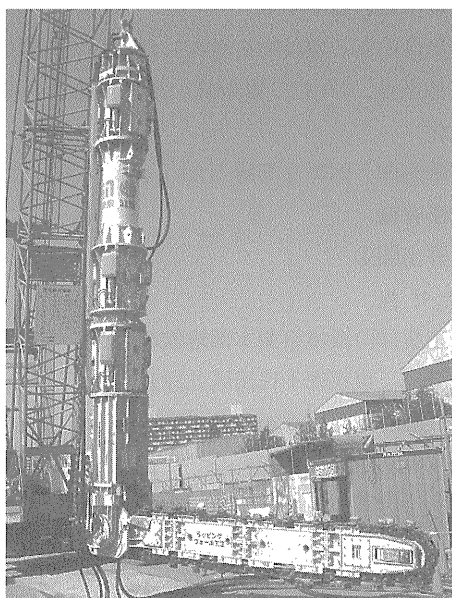
写真-1 掘削機全景
