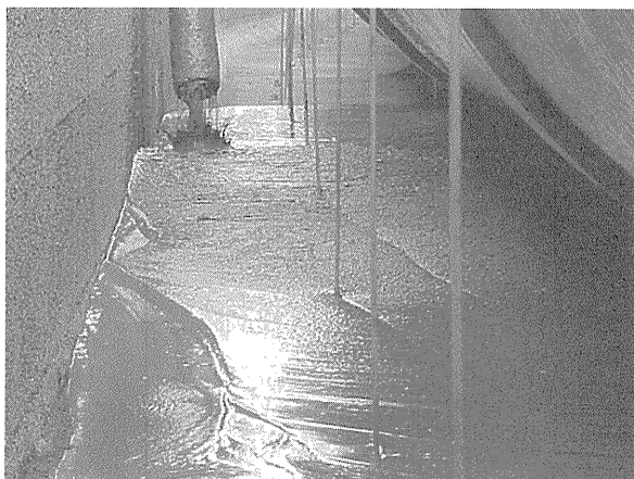
写真—7 打設状況
