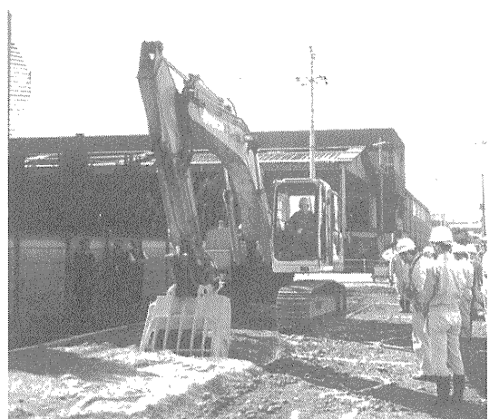
写真-2 試験施工状況
