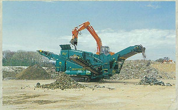
⇩混合廃棄物の現場内で分級、選別
