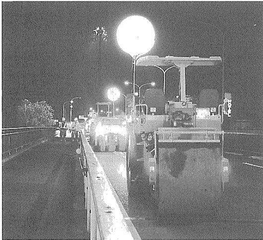
写真—16 ローラーに取付けたルミエアー
