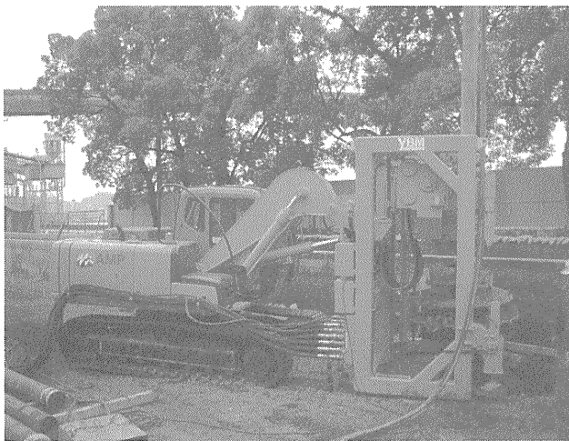
写真-13 AMP 工法施工機械
