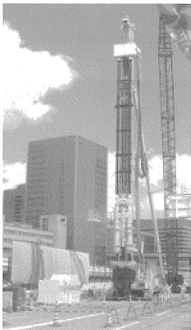
写真一七 施工状況
