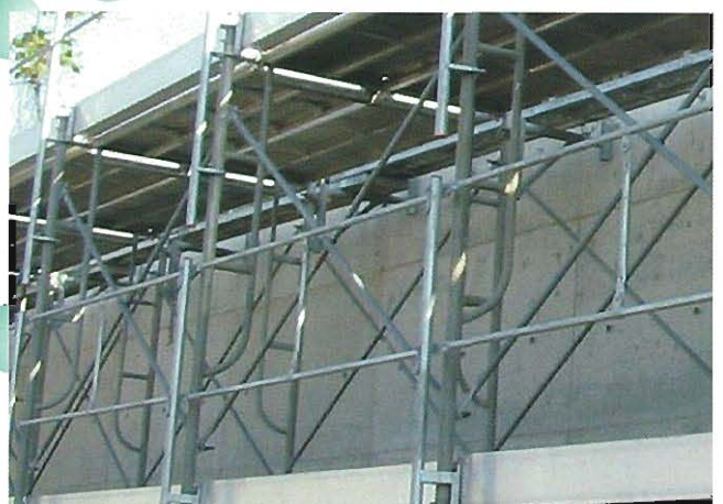
⇨2段手すりの例
