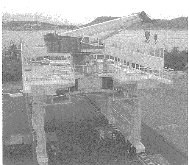
写真-2 移動式直接高架施工機
