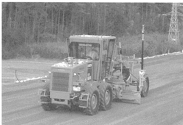
写真一八 3D-MC モータグレーダによる高速道路における路盤整形作業
