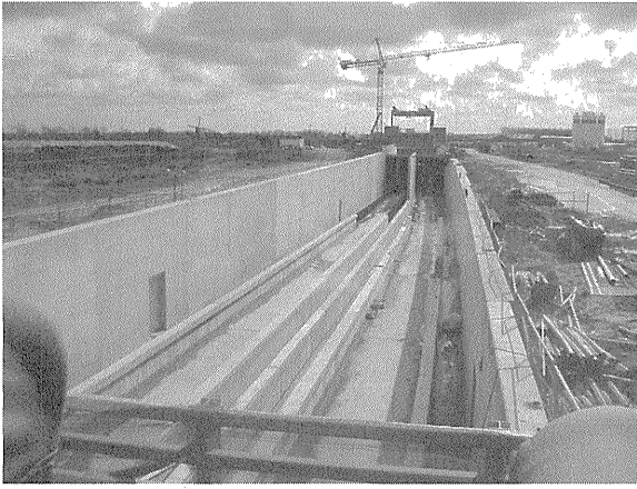
写真—53 掘込み部の工事状況
