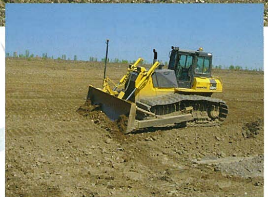
⇨法面整地状況
