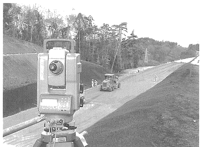
写真-3 3D-MC グレーダ施工状況
