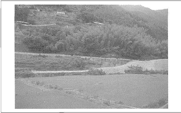
写真一 実証実験現場の全景
