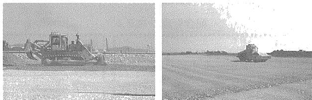
⑤ 約 50 cm に土砂撒出し敷均し
