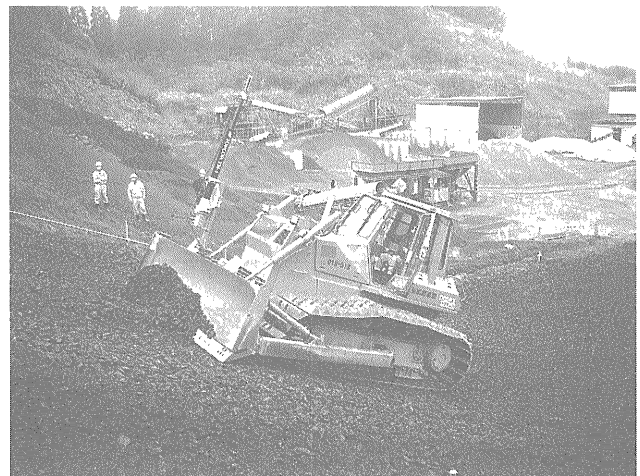
写真-4 ブルドーザによる路盤整正作
