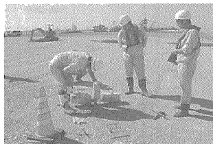
⑦ 締固め後の密度試験
