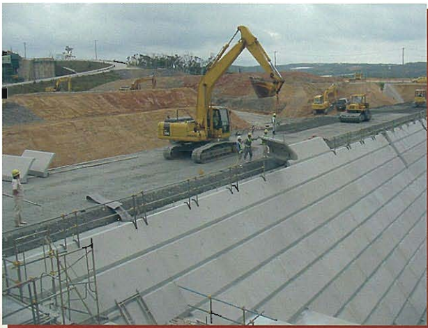
⇩ プレキャスト型枠設置状況
