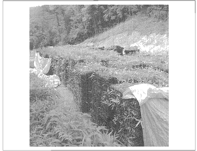
写真—7 表土マットの仮置き（採取後3ヵ月）
