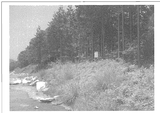
写真-11 施工後約2年経過（平成16年6月）
