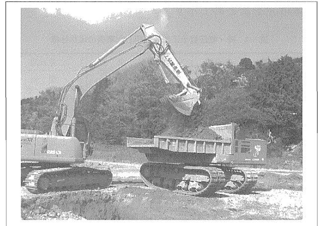
写真—4 バケット式解砕機による解砕状況
