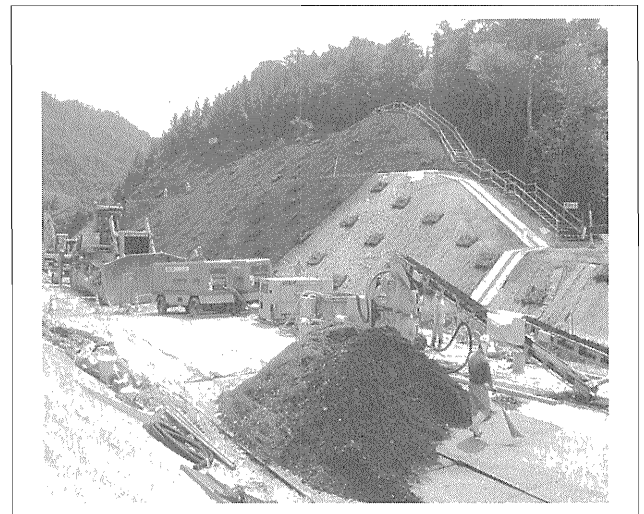
写真-12 建設発生木材と表土を混合した基盤材の吹付け
