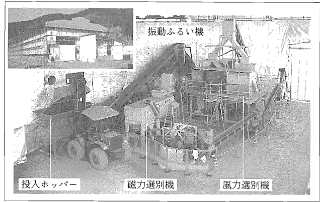
写真一4 プラント建屋およびプラント全景
