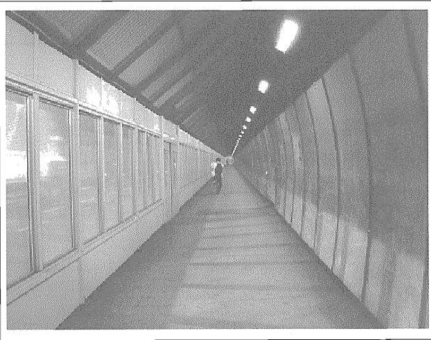
写真-5 対策工完成後のトンネル内歩道部
