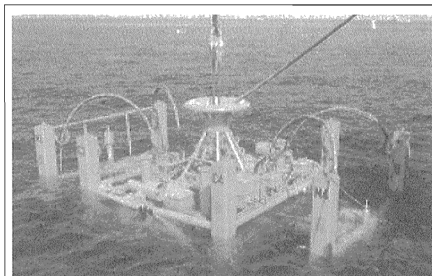
(a) 水中捨石均し機
