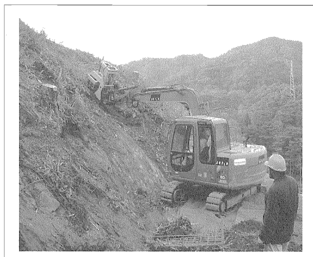
写真—5 急傾斜地での採取状況
