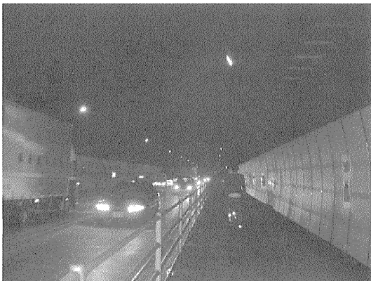
写真-1 対策前のトンネル内歩道部状況
