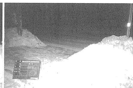
写真-7 人力施工（施工後）
