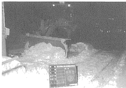
写真-9 機械施工（施工中）
