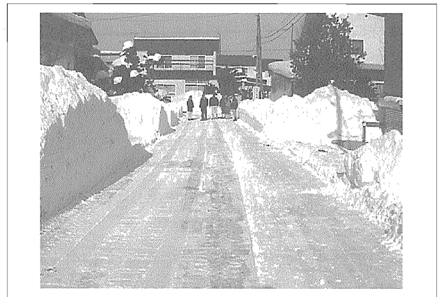
写真—13 除雪後の生活道路の状況
