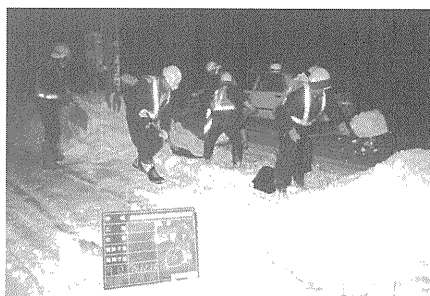
写真-6 人力施工（施工中）
