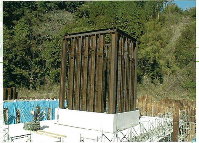
⇨ スパイラルカラム第1ロット: 第1ロットのスパイラルカラムの建込み精度は、その後の施工精度に大きく影響するため、各スパイラルカラムの頭部を連結し、フーチングコンクリートを打設します。
