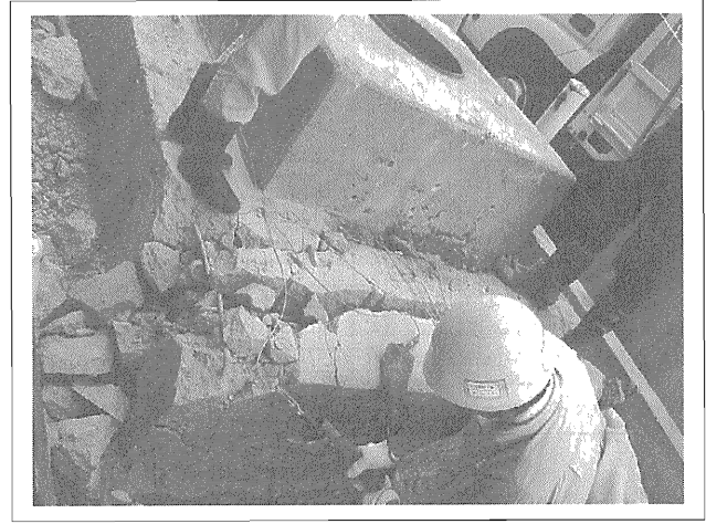
写真一九 旧歩道橋基礎部の破砕状況
