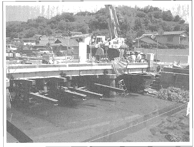
写真-1 橋の解体撤去工事(事例1)
