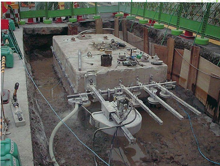
⇩ 国道の中央分離帯内工事
