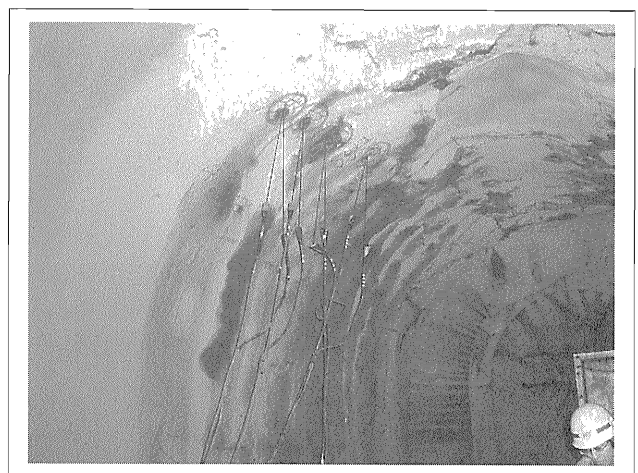
写真-6 防火扉戸溝掘削の施工前
