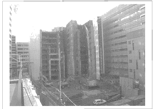
写真—5 四折れアタッチメントによる解体風景
