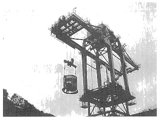
写真—1 ハザマクライミングリフトバケット (9 m 3 ) 揚重状況
