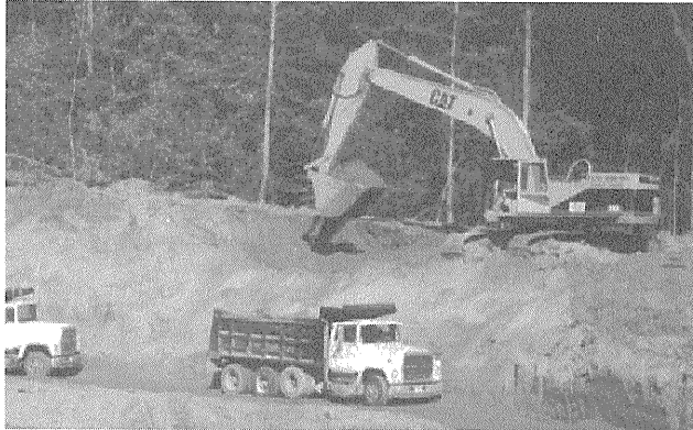
写真一 大規模土工における土砂の掘削・積込み
