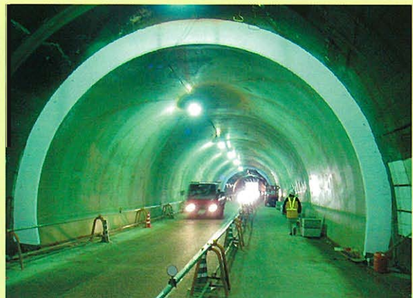
写真-17 / 二次覆工コンクリート (写真提供: 国交省)
