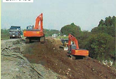
↑写真-2 / 応急復旧工事 (3点とも本文の参考文献1)より
