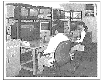
写真二 遠隔操作状況
