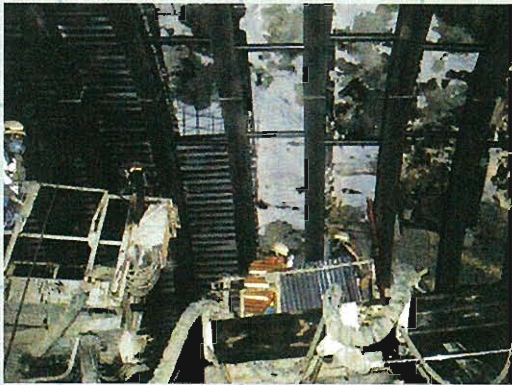
写真-15 / 断面修復状況 (写真提供: 国交省)
