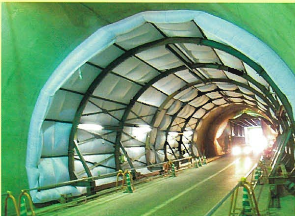
写真-16 / エアーマット養生 (凍害防止) (写真提供: 国交省)
