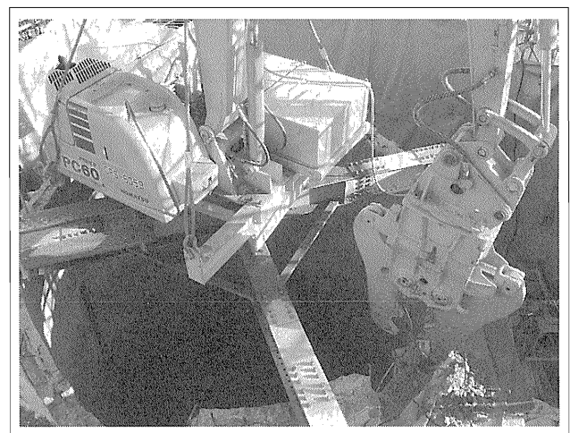
写真-6 コンクリート躯体の解体状況
