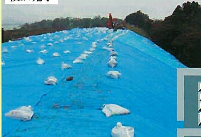
↑写真-3 / 応急復旧後の状況
