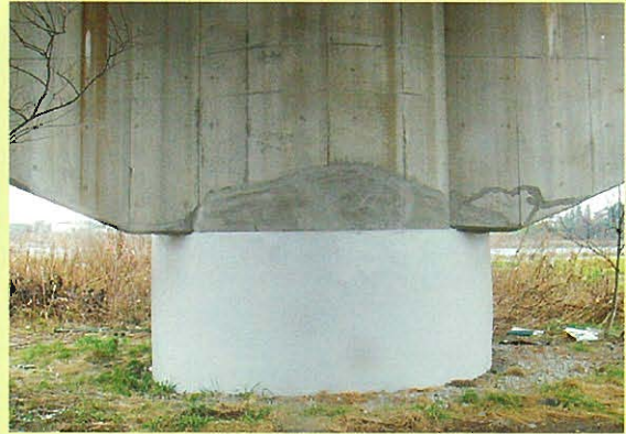
写真-14 / 橋脚の補修後の状況 (写真提供: 国交省)
