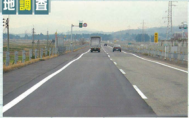
写真-11 / 長岡市付近の関越道上り線
