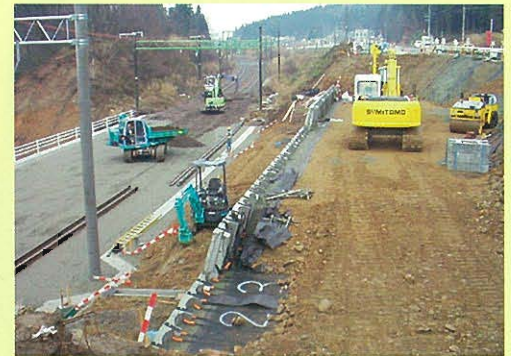
⇩写真-21 / 国道17号線側の法面復旧施工状況 (写真提供:国交省)
