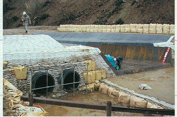
⇩写真-19 / 完成した排水施設
