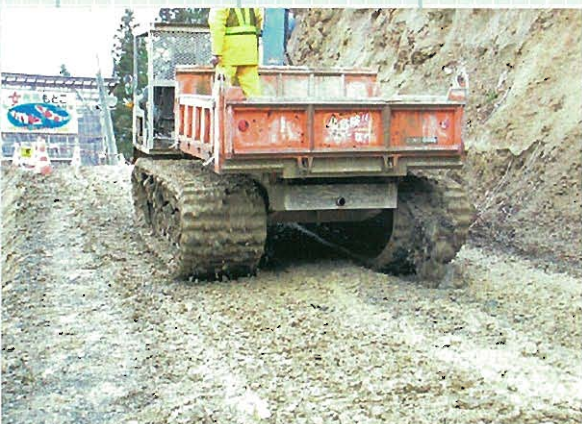
写真-32 / 寺野地区の不整地運搬車
