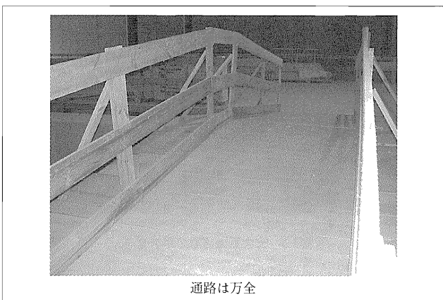
写真—5 通路養生の安全設備
