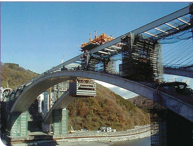
↑PC床版架設足場
