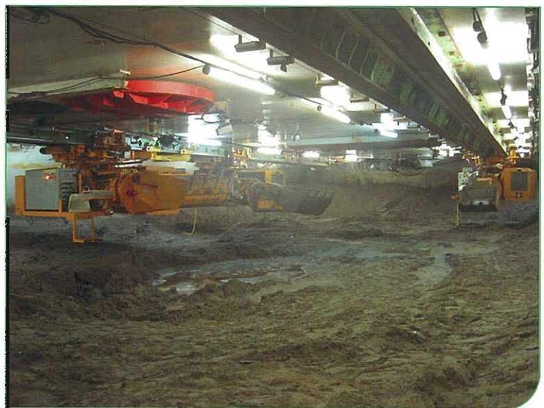
↑函内状況 遠隔操作掘削(天井走行式掘削機3機)
