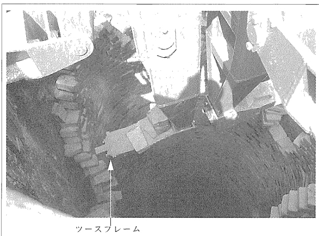
写真1 煙突内煉瓦解体状況
