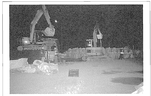
写真-3 夜間大型土のう製作
