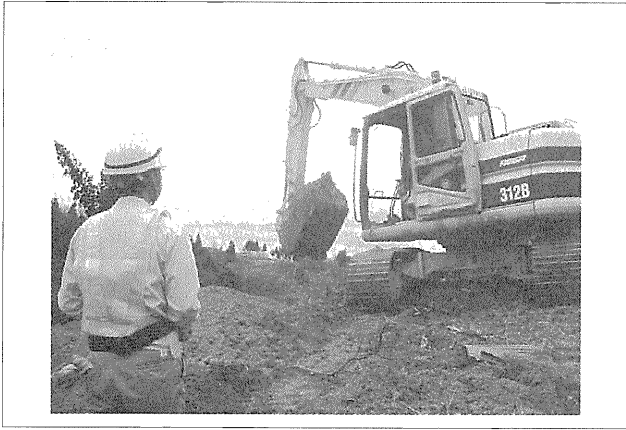
写真—10 組立て完了（試運転）
