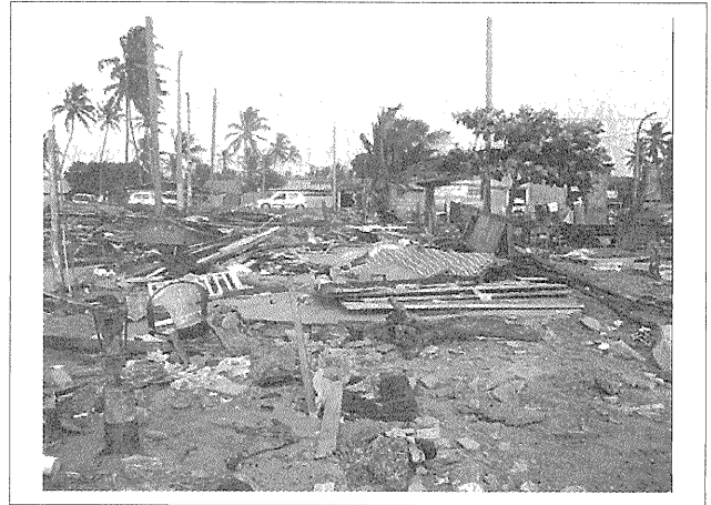
写真-5 Moratuwaにおける沿岸住居の被害
