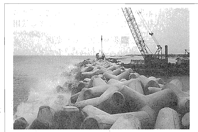
写真-6 消波ブロック式防波堤
