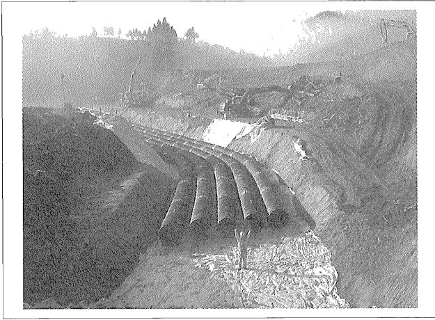
写真-10 仮設排水管敷設完了
