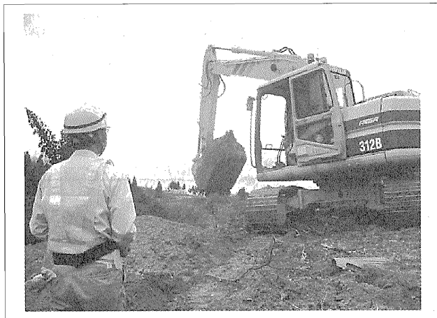
写真-3 山古志村東竹沢地区の無人化施工（平成16年11月）
