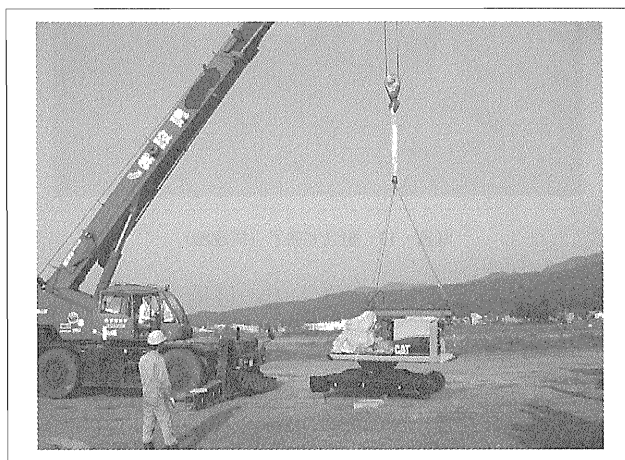
写真—7 現地での吊り試験
