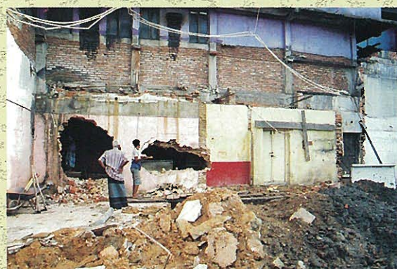
⇩G-7 建物の解体(ゴール)
