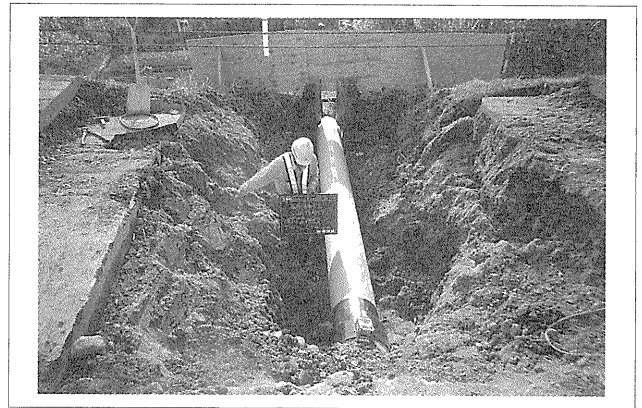
写真-4 横断排水管復旧
