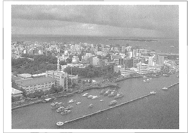
写真-4 マレ島北護岸(離岸堤)
