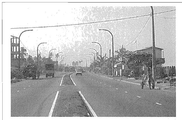
写真-1 道路 (A2号線) の状況
