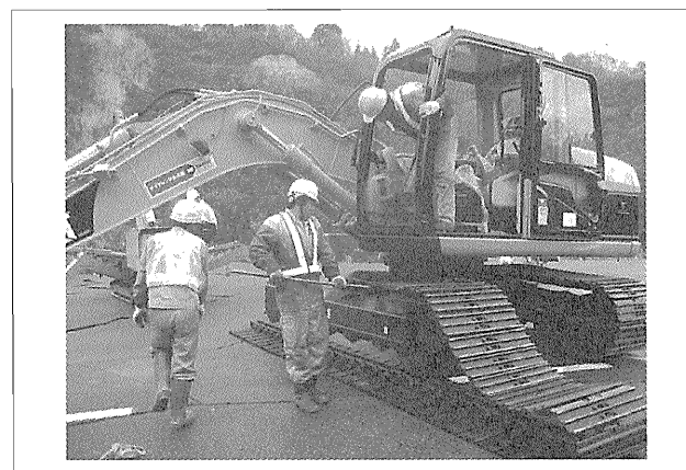
写真—9 現地組立て作業
