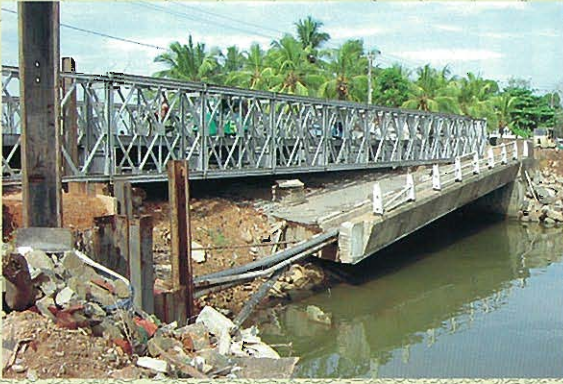
↑G-8 応急組立橋(ゴール)
