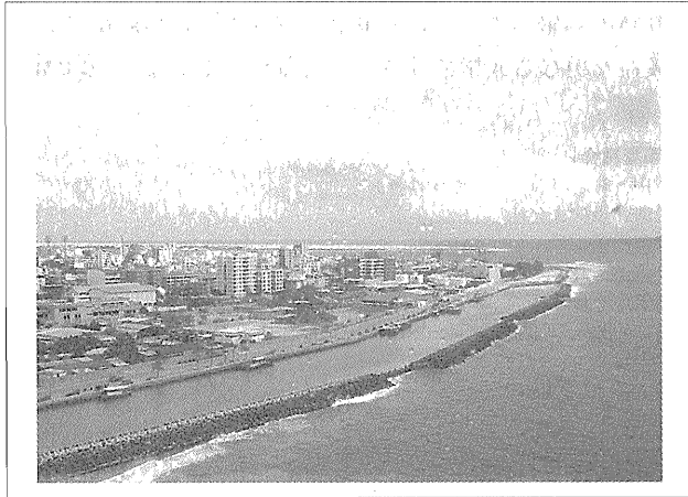
写真-1 マレ島南防波堤と南護岸
