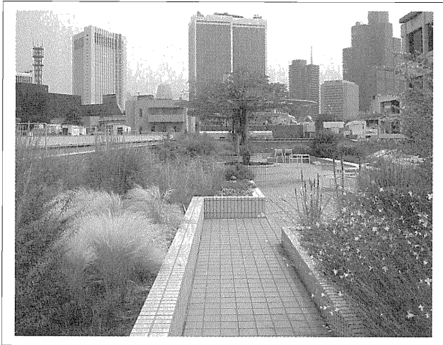
写真—1 軽量土壌を用いた実施例（鹿島KIビル）
