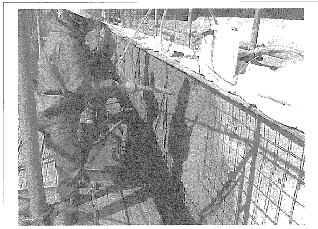
写真-4 吸音材吹付け作業状況
