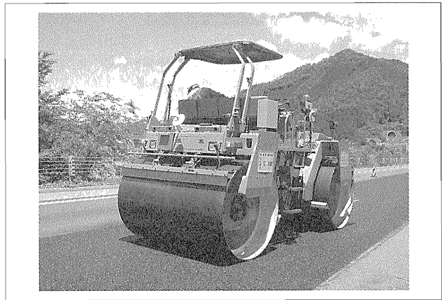
写真一六 ワイドローラ「SW 720 B 改」(高速道路切削オーバーレイ工事における高機能舗装を転圧中)
