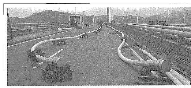
写真—8 再生が完了したケーブル
