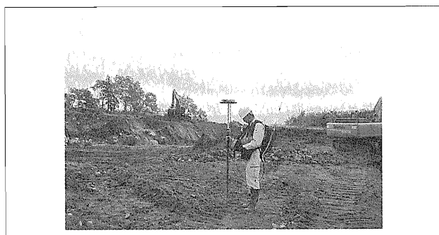
写真—1 3D-NAViによる測定状況
