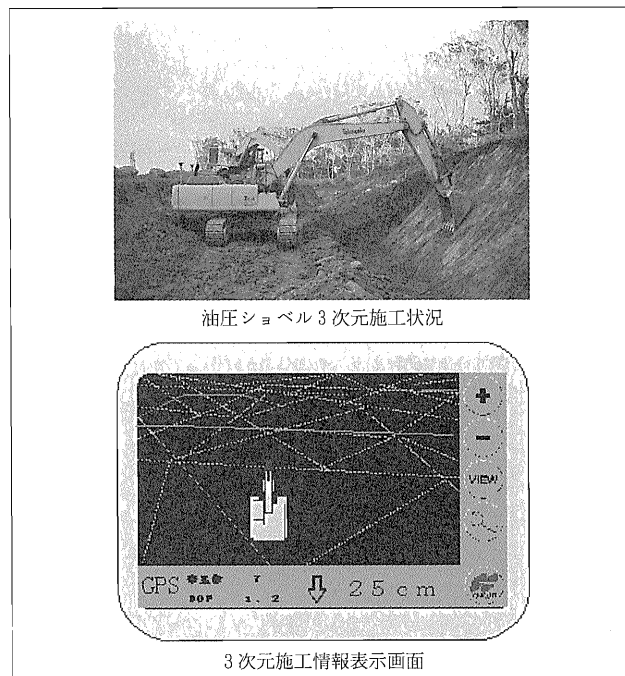
写真—3 3D-MC ショベルによる施工状況
