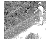
パークブローア機で大幅な工期短縮が可能
