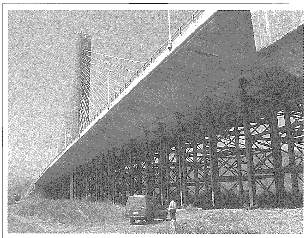
写真-4 ベントの設置状況
