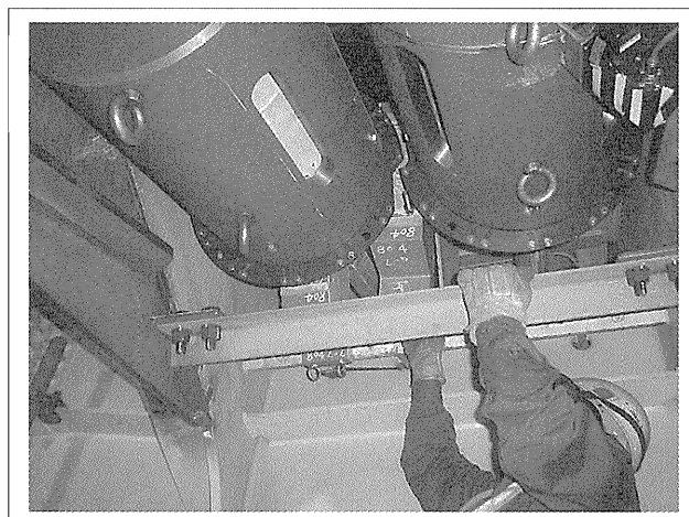
写真-5 座金, シム調整状況
