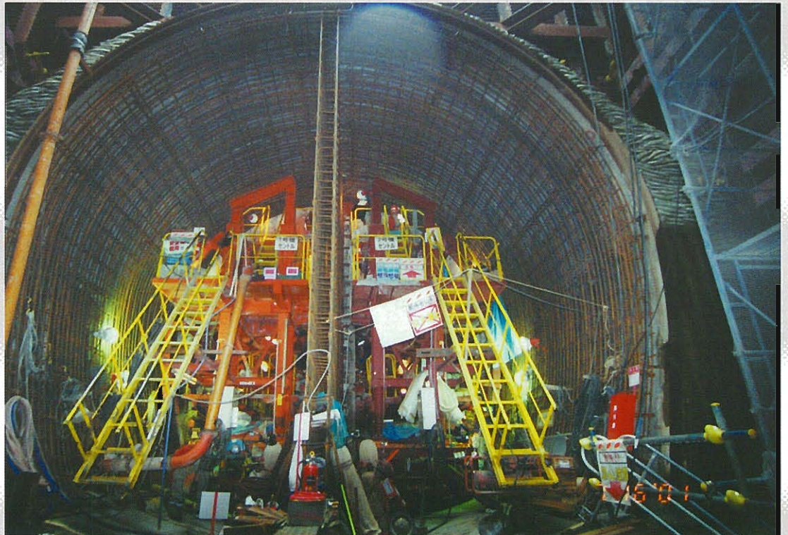
垂直隔壁を有する舞鶴火力発電所取水水路トンネル工事
