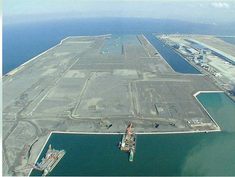
↑関空2期埋立2次揚土工事全景
