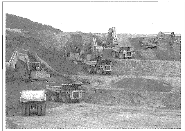
写真—5 190t油圧ショベルと90tダンプトラック（谷浜造成）
