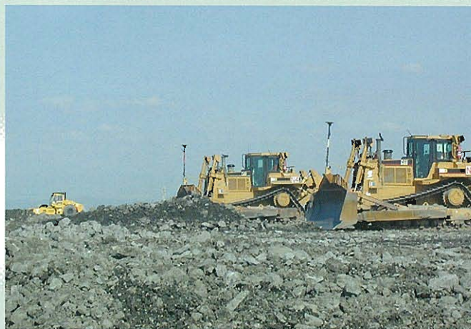
↑GPSドーザによる敷均厚管理(全車GPS装着)
