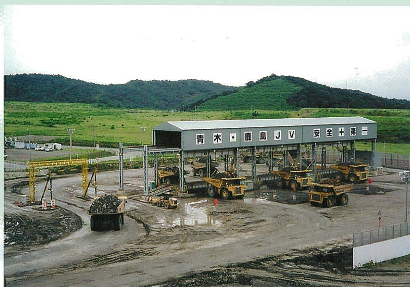
↑加太土取場のベルコン投入口と90tダンプ
