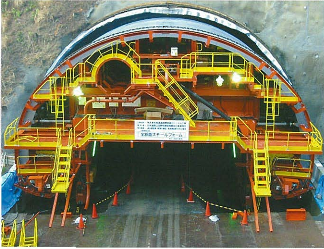
第二東名静岡第三トンネル工事のセントル
