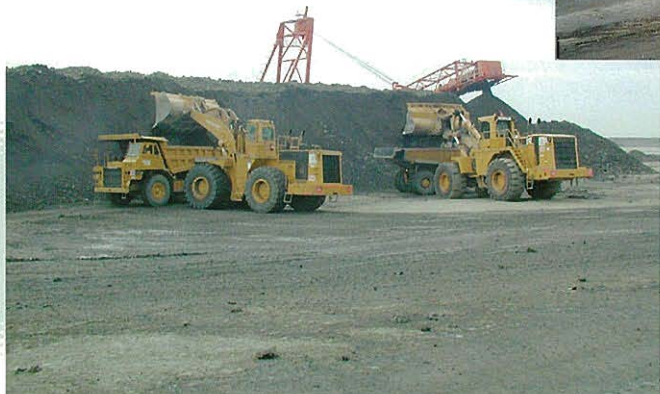
↑2次揚土の積み込み(10~13m 3 ローダ)
