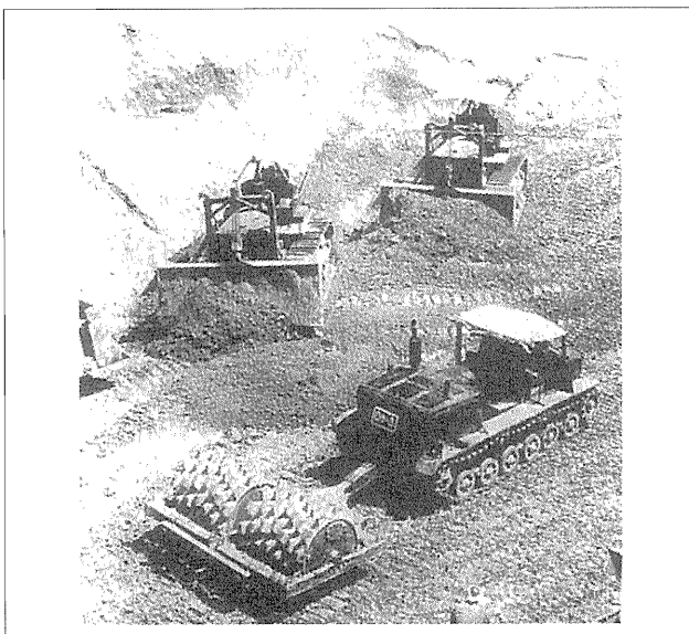
写真—3 信濃川発電所コア締固め
