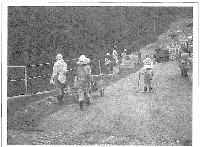
写真-7 下流面ブロック型枠
