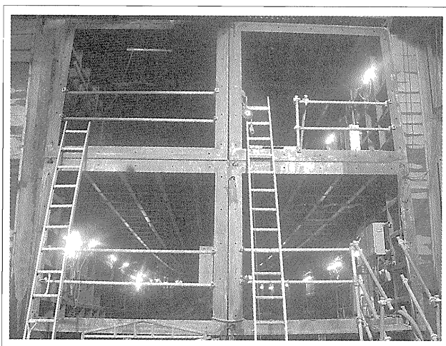
写真—2 4 函体推進完了状況
