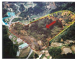
被災状況(H16.10.24)
