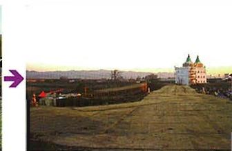
仮締切堤完了(H16.12.3)
