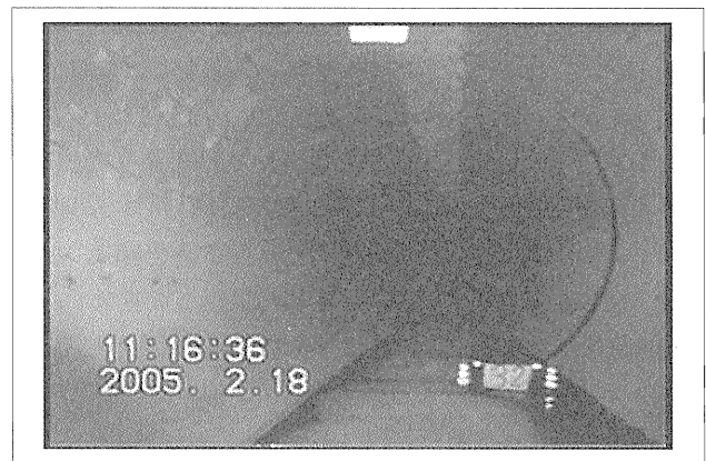
写真—4 立坑から約1.3 km離れた地点からの受信画像
