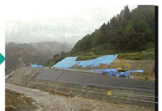
復旧状況(H17.9.30)
