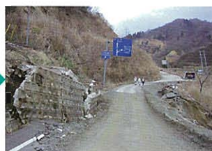
応急復旧状況(H16.12.21)
