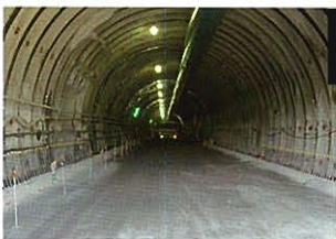
付け替えトンネル内部(H17.9.29)
