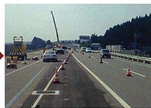
本復旧状況(H17.9)
