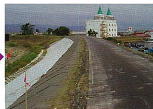
復旧工事完了(H17.10.6)
