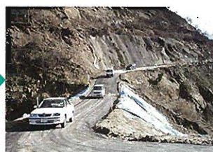
工事用道路を通行(H16.12.5)
