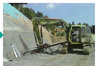
復旧状況(H17.9.23)
