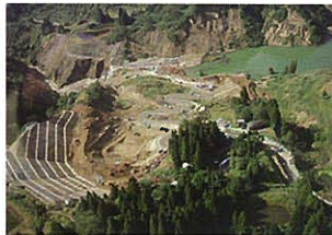
復旧状況(H17.10.12)
