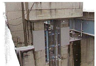
7号ピア復旧完了(H17.2.22)
