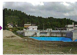
現在の復旧状況(H17.10)
