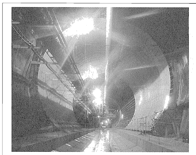
写真-2 アーチライナ施工状況
