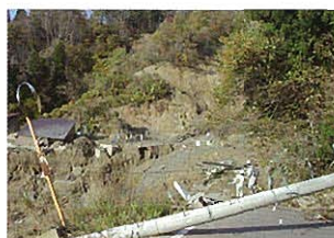
被災状況(H16.11.5)
