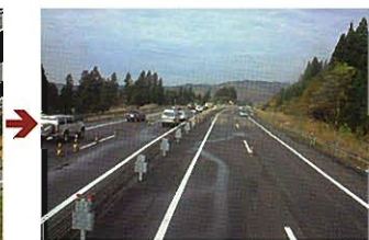
4車線化工事完了(H16.11.26)
