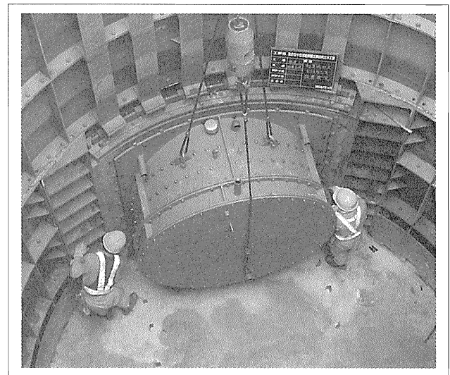
写真—5 エントランス設置状況
