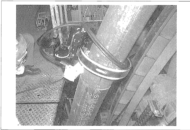
写真-4 鋼管の自動溶接
