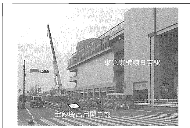
写真-1 土砂搬出場所全景
