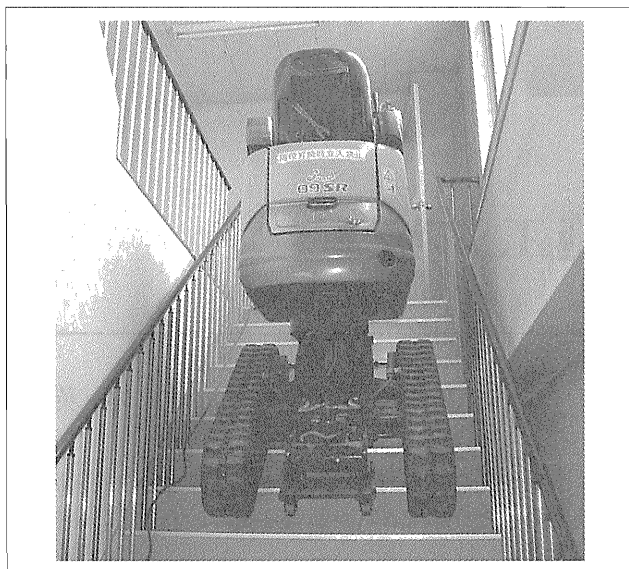
写真-5 階段を昇降する解体機
