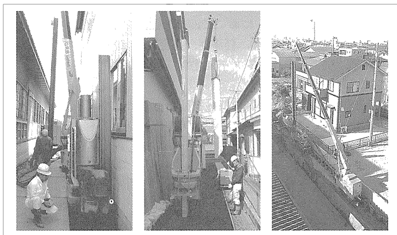
写真—8 狭隘地クリア工法
