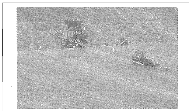
写真—7 レーザ誘導式自動操舵アスファルトフィニシャ
