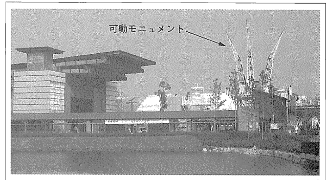
図-3 長久手愛知県館の全体
