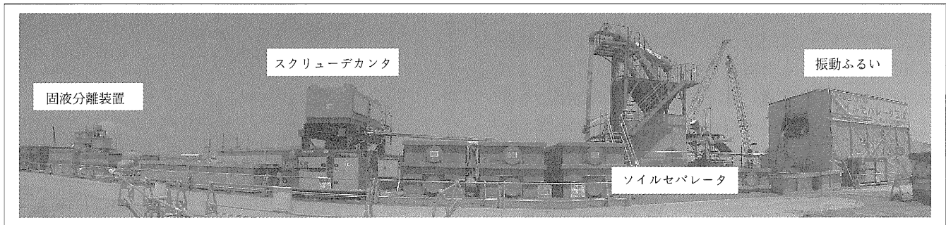
写真-6 現場全景
