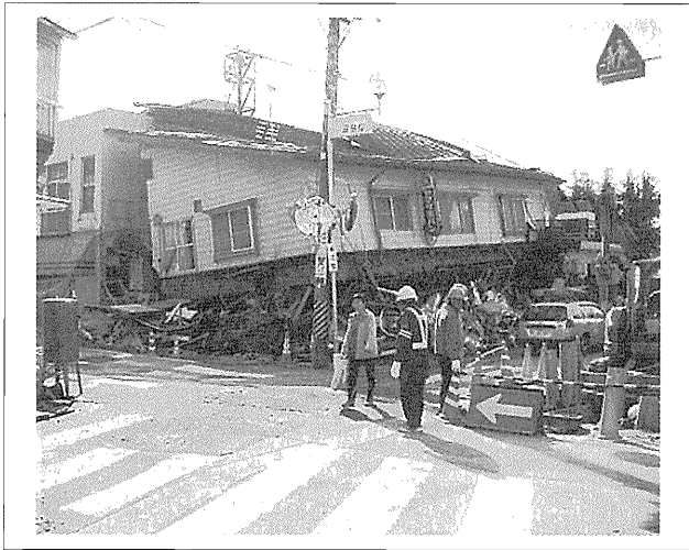
写真—4 建物の被災（川口町）
