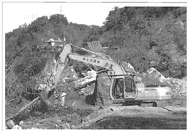
写真-6 無人化施工機械の活躍
