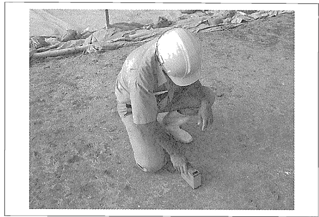
写真-3 誘電率測定状況
