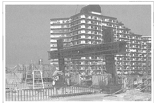
写真—6 鉄骨建方状況（サの字型）
