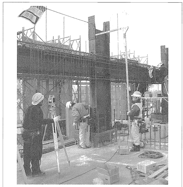
写真-4 測定治具を使用した歪直し作業
