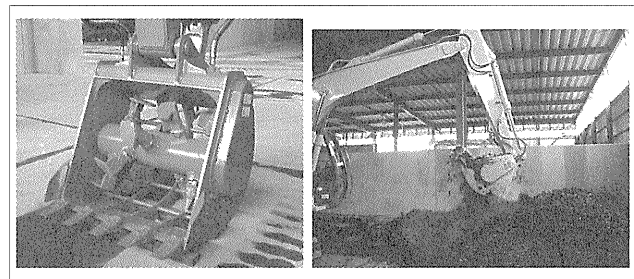
写真-3 混合機および生石灰混合状況
