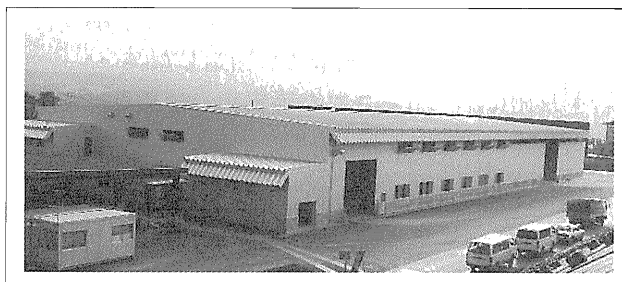
写真-1 プラント建屋全景
