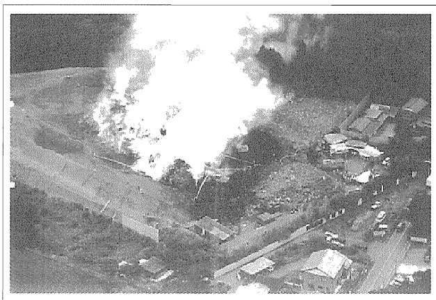
写真—1 堆積された木材チップの火災（平成 15 年 8 月）
