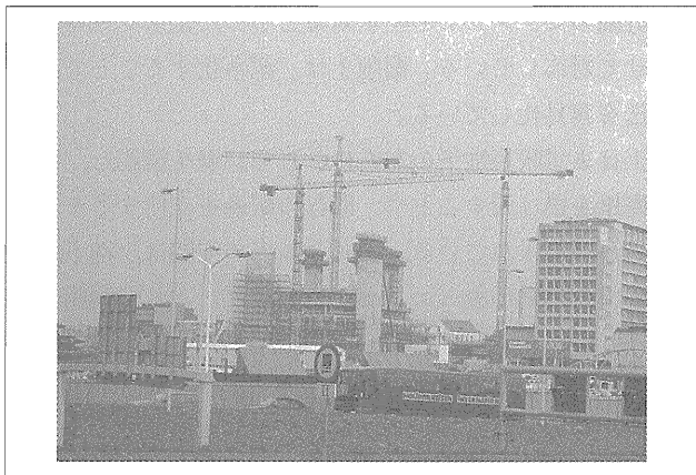
写真—33 トンボクレーンを使用した施工
