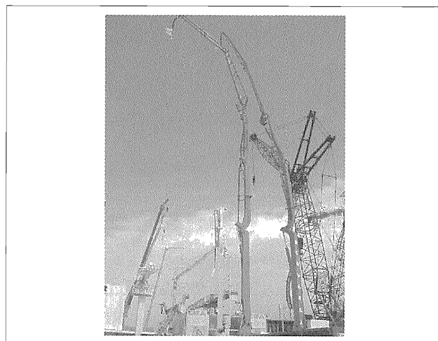
写真-21 コンクリートポンプ車
